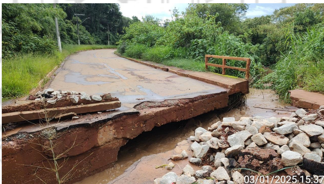
Foto 02 - Local de implantação da canalização do Córrego Do Ferreira em aduelas pré-moldadas em concreto na Rua Antônio João Vieira
