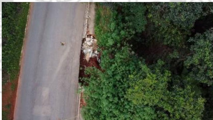
Foto 05 – Local das erosões – Fonte: Defesa Civil – Ouro Branco
