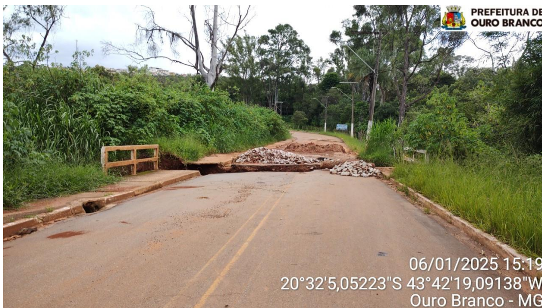
Foto 03 - Local de implantação da canalização do Córrego Do Ferreira em aduelas pré-moldadas em concreto na Rua Antônio João Vieira
