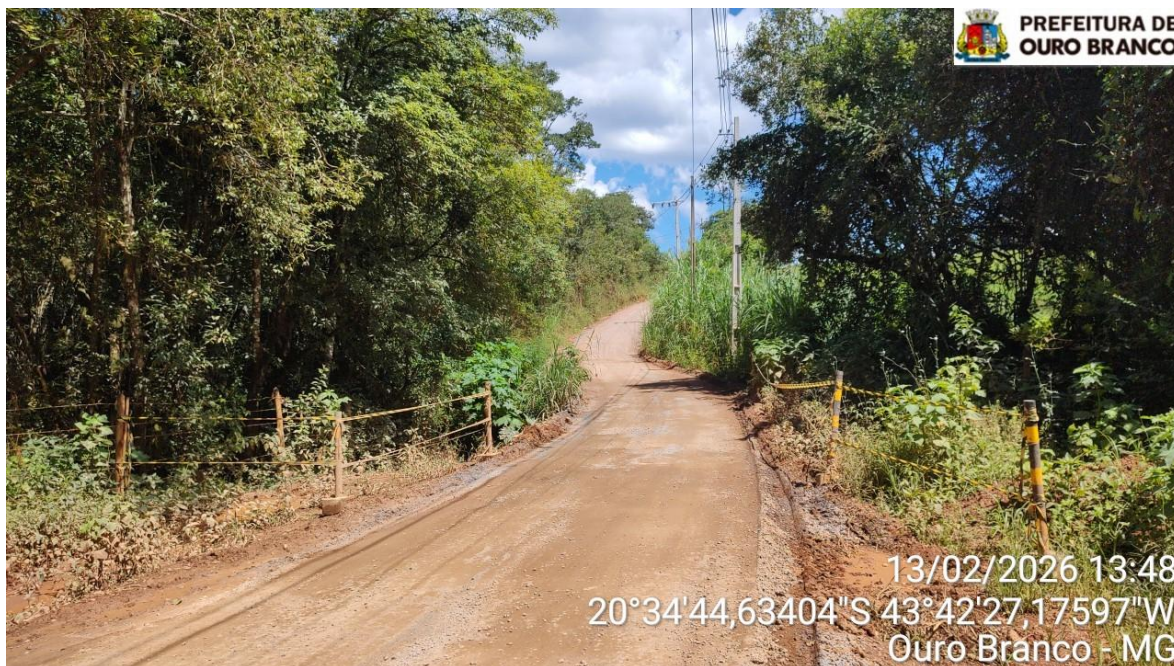
Foto 02 – Ponte existente no local
