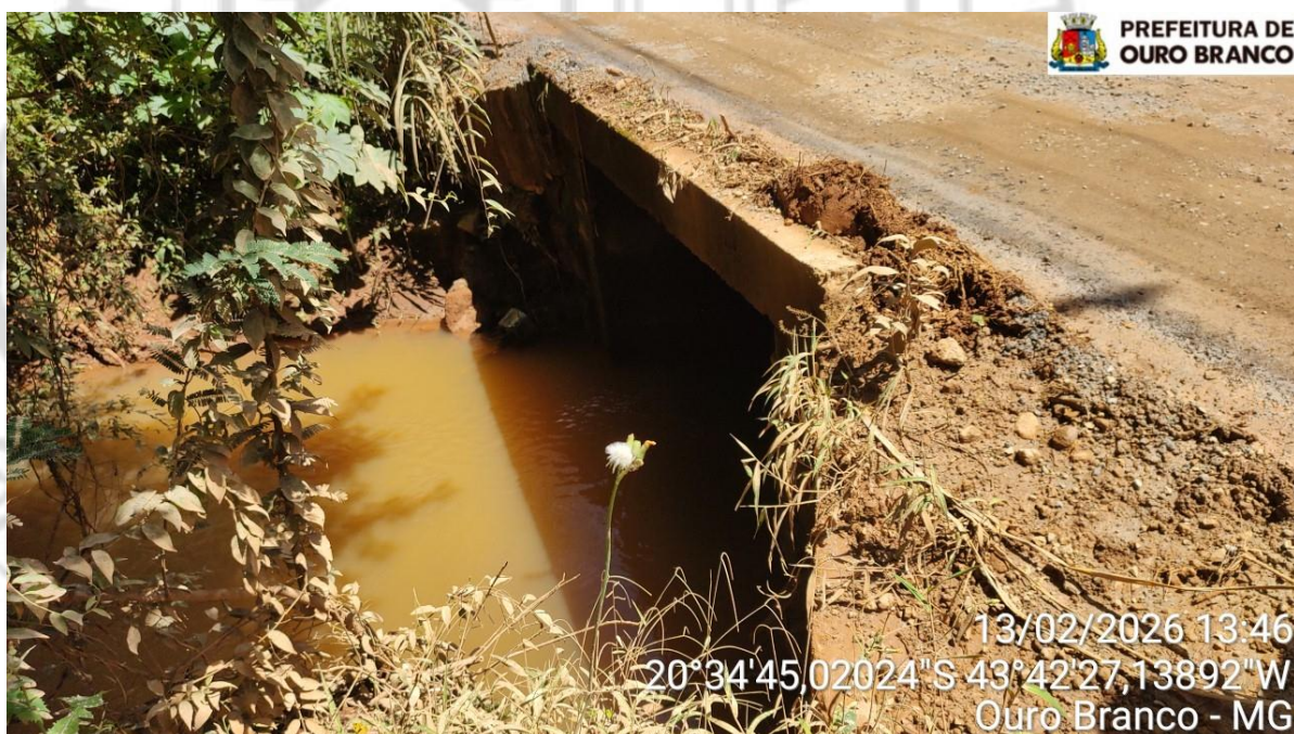
Foto 03 - Ponte existente no local
