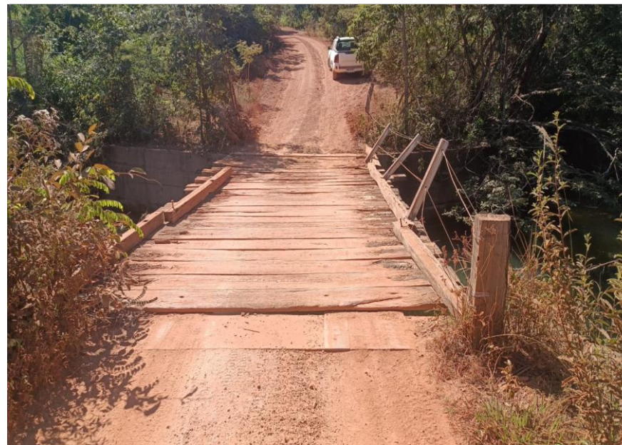
Descrição: Ponte Córrego Alforges
