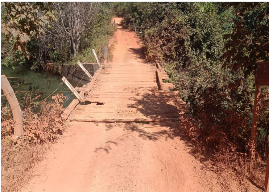
Descrição: Ponte Córrego Alforges
