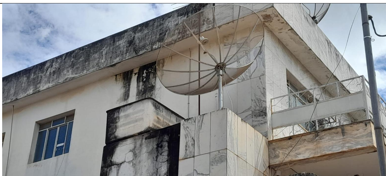
FACHADA LATERAL DIREITA
