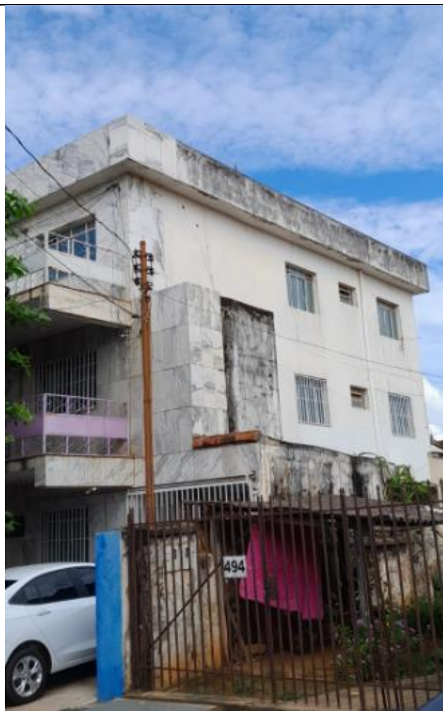
FACHADA LATERAL ESQUERDA DO PRÉDIO
