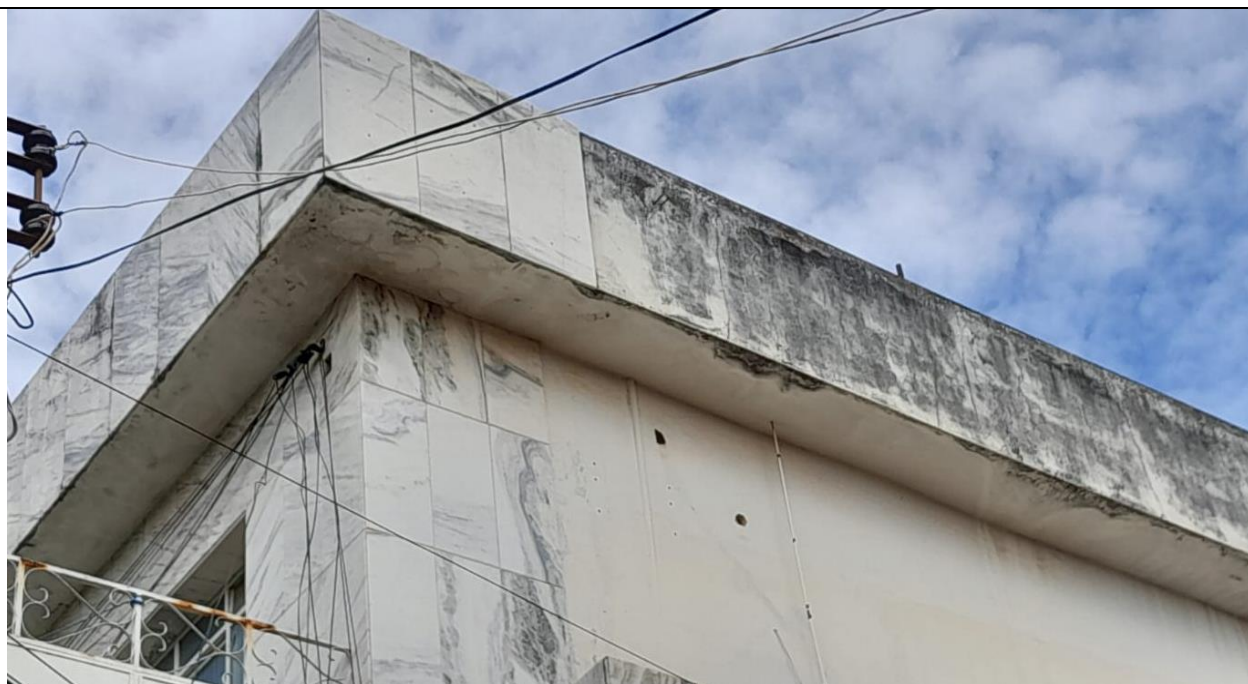
FACHADA LATERAL ESQUERDA – BEIRAL
