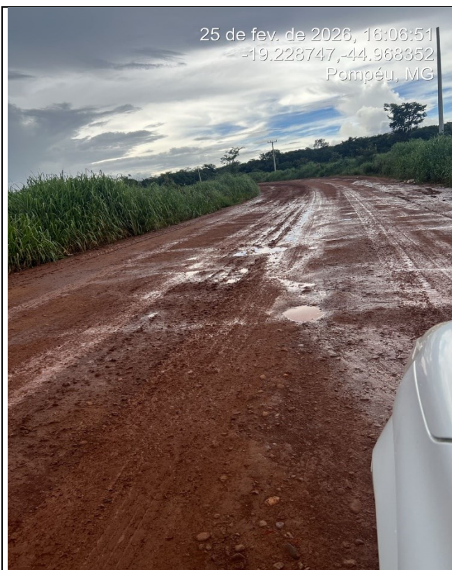
OBSERVAÇÃO: ESTRADA VICINAL
