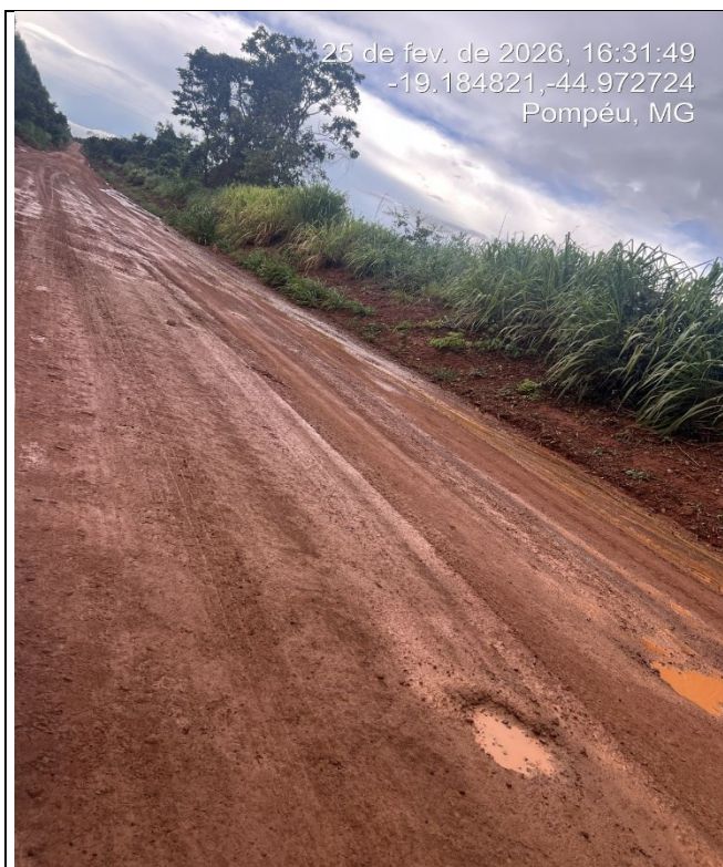
OBSERVAÇÃO: ESTRADA VICINAL
