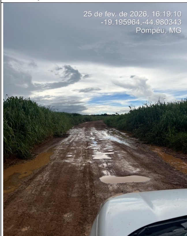
OBSERVAÇÃO: ESTRADA VICINAL
