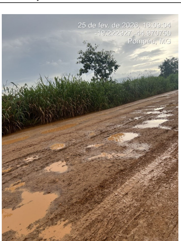
OBSERVAÇÃO: ESTRADA VICINAL
