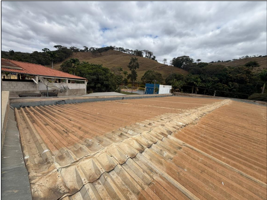
Foto 07 – Telhado a ser reformado
