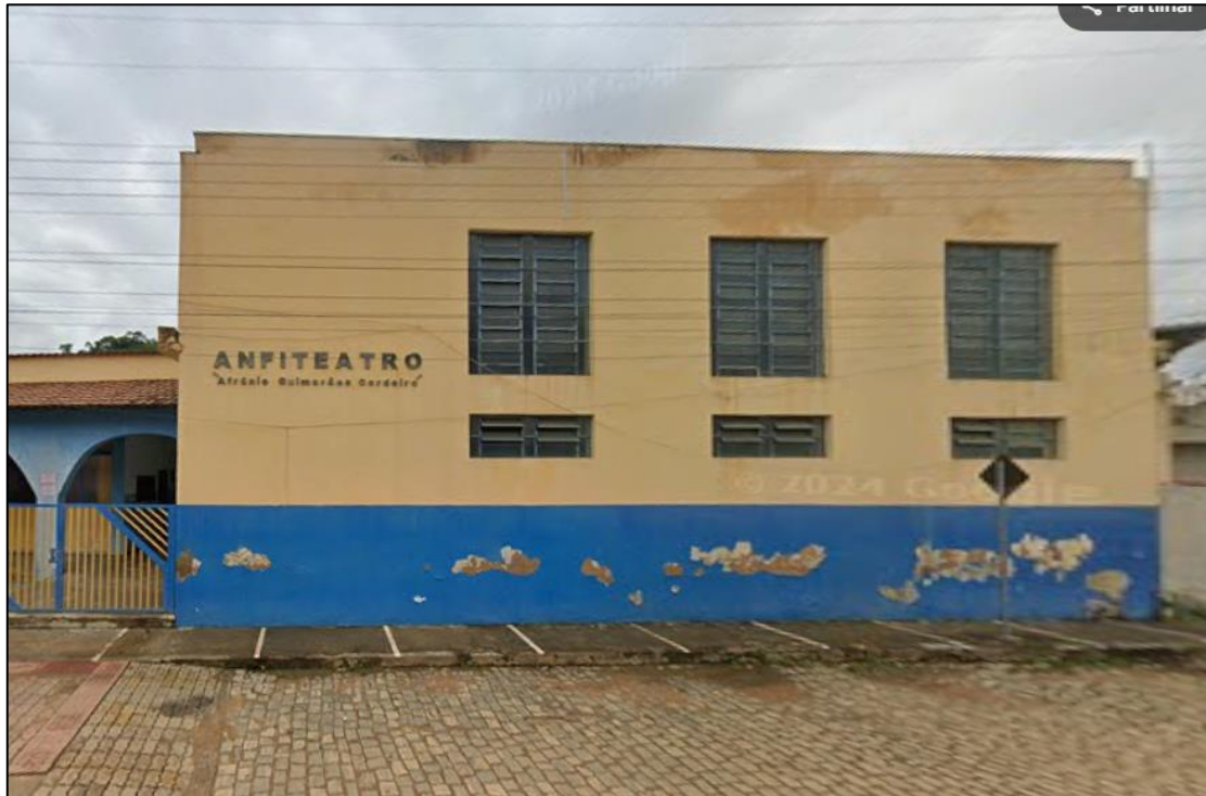
Foto 01 – Fachada a ser reformada
