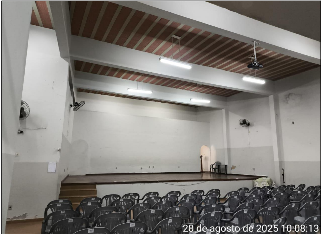
Foto 05 – Vista interna do anfiteatro
