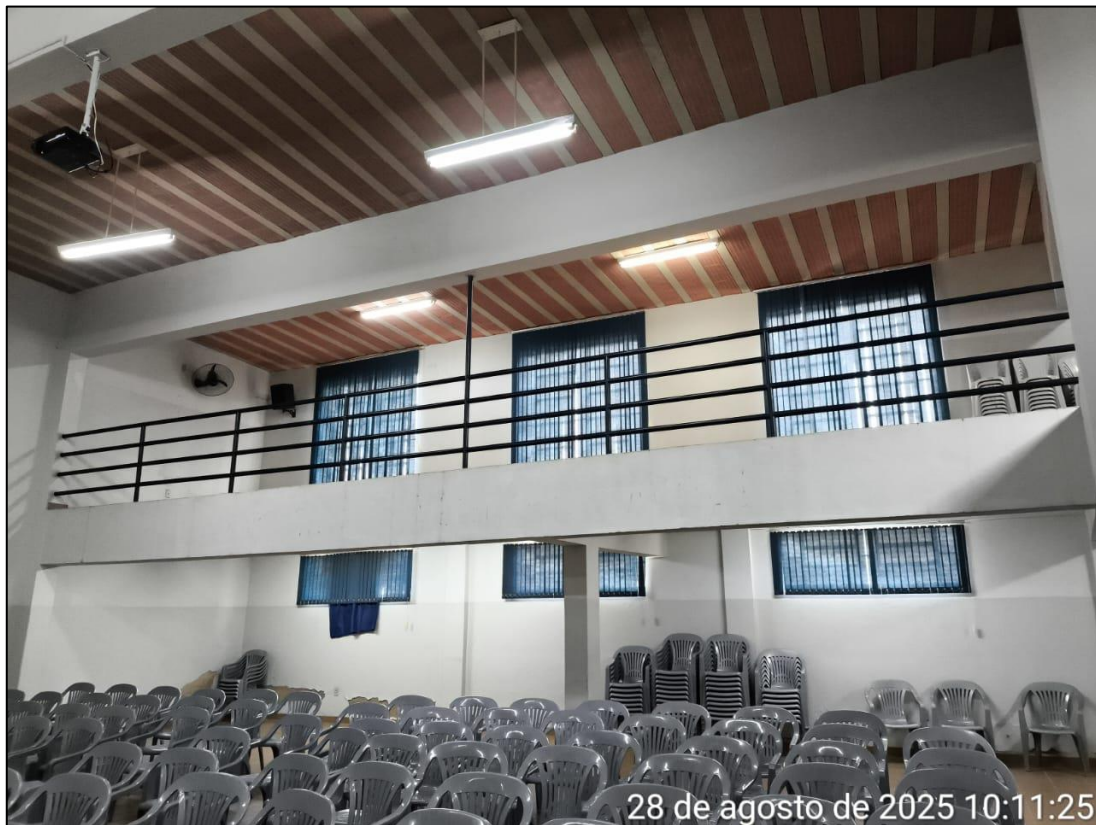
Foto 02 – Vista interna do anfiteatro
