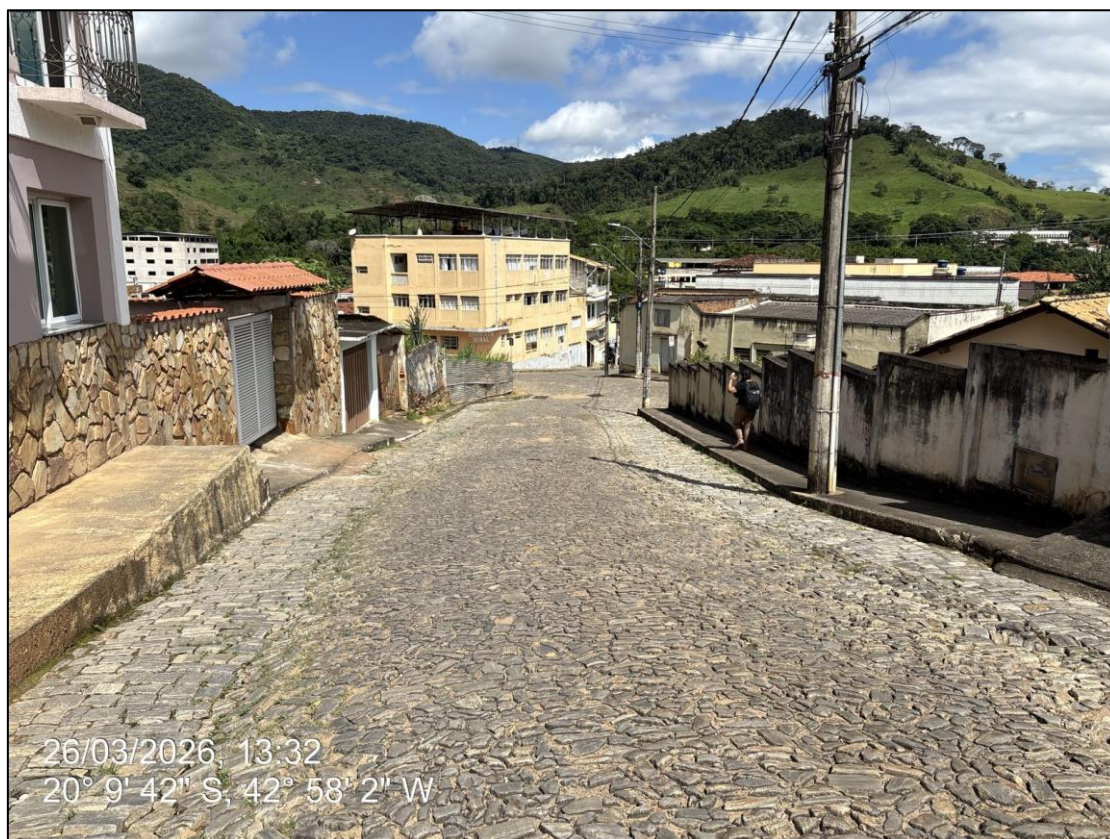
Foto 06- Local onde será executado o calçamento em paralelepípedo
