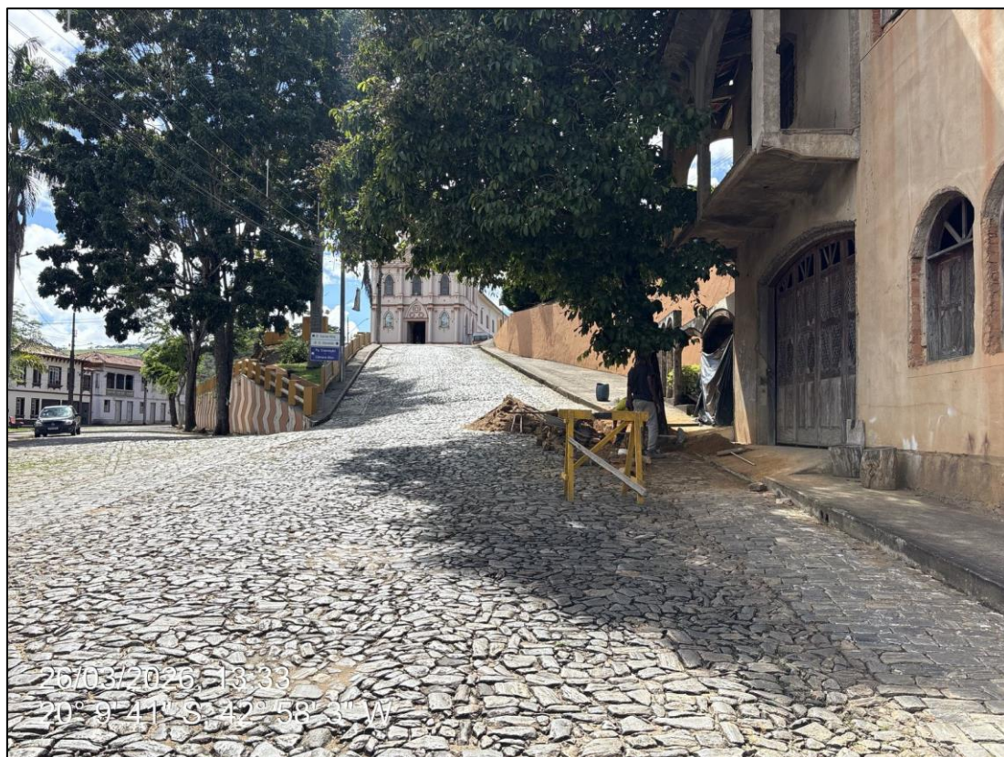
Foto 05- Local onde será executado o calçamento em paralelepípedo
