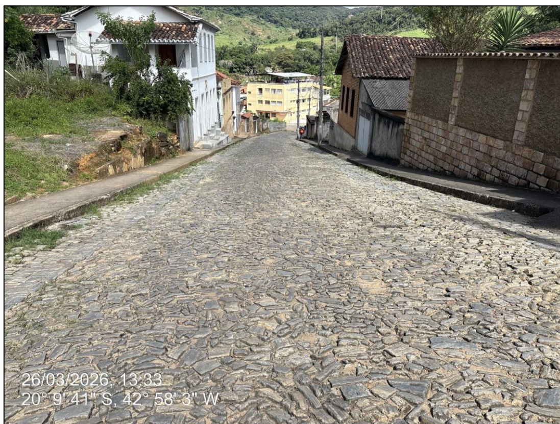
Foto 04- Local onde será executado o calçamento em paralelepípedo
