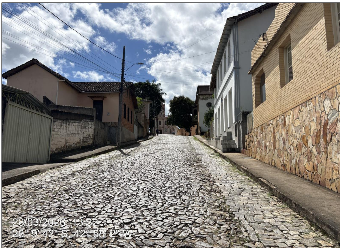
Foto 07- Local onde será executado o calçamento em paralelepípedo
