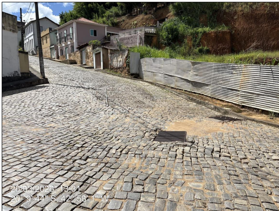
Foto 08- Local onde será executado o calçamento em paralelepípedo
