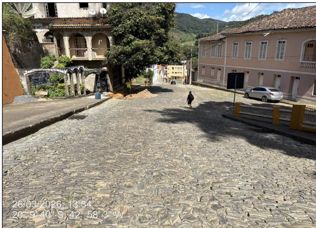
Foto 02- Local onde será executado o calçamento em paralelepípedo
