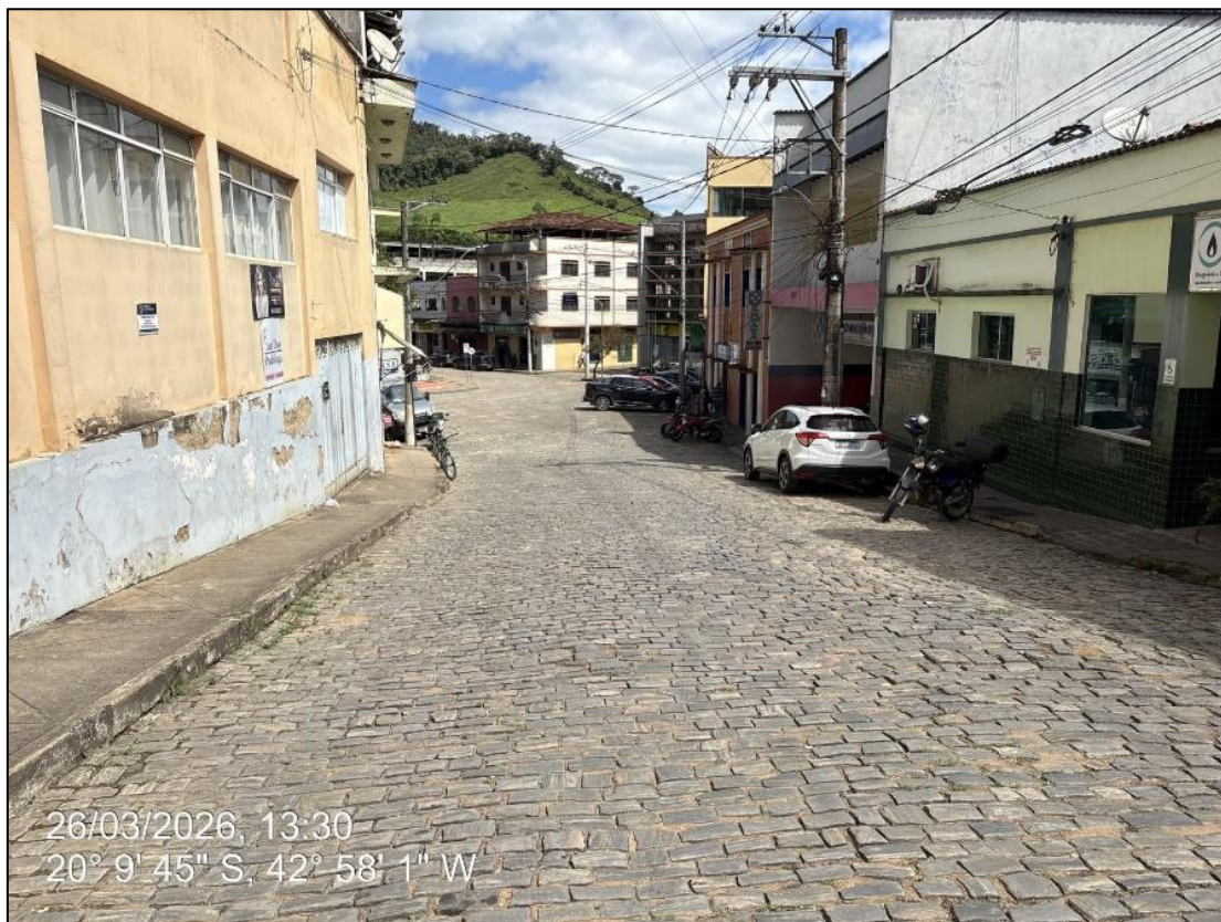
Foto 10- Local onde será executado o calçamento em paralelepípedo
