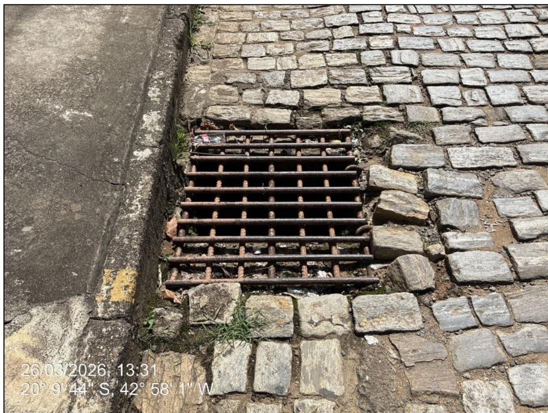
Foto 09- Grade existente a ser pintada
