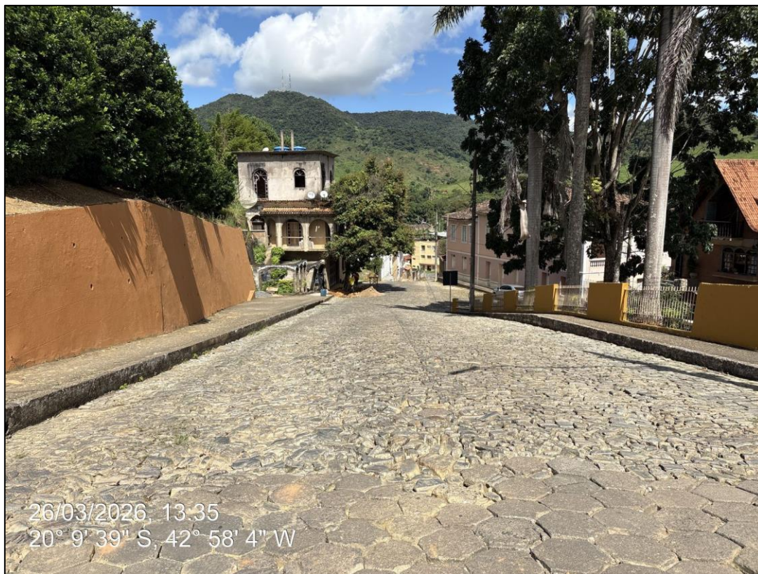
Foto 01- Local onde será executado o calçamento em paralelepípedo
