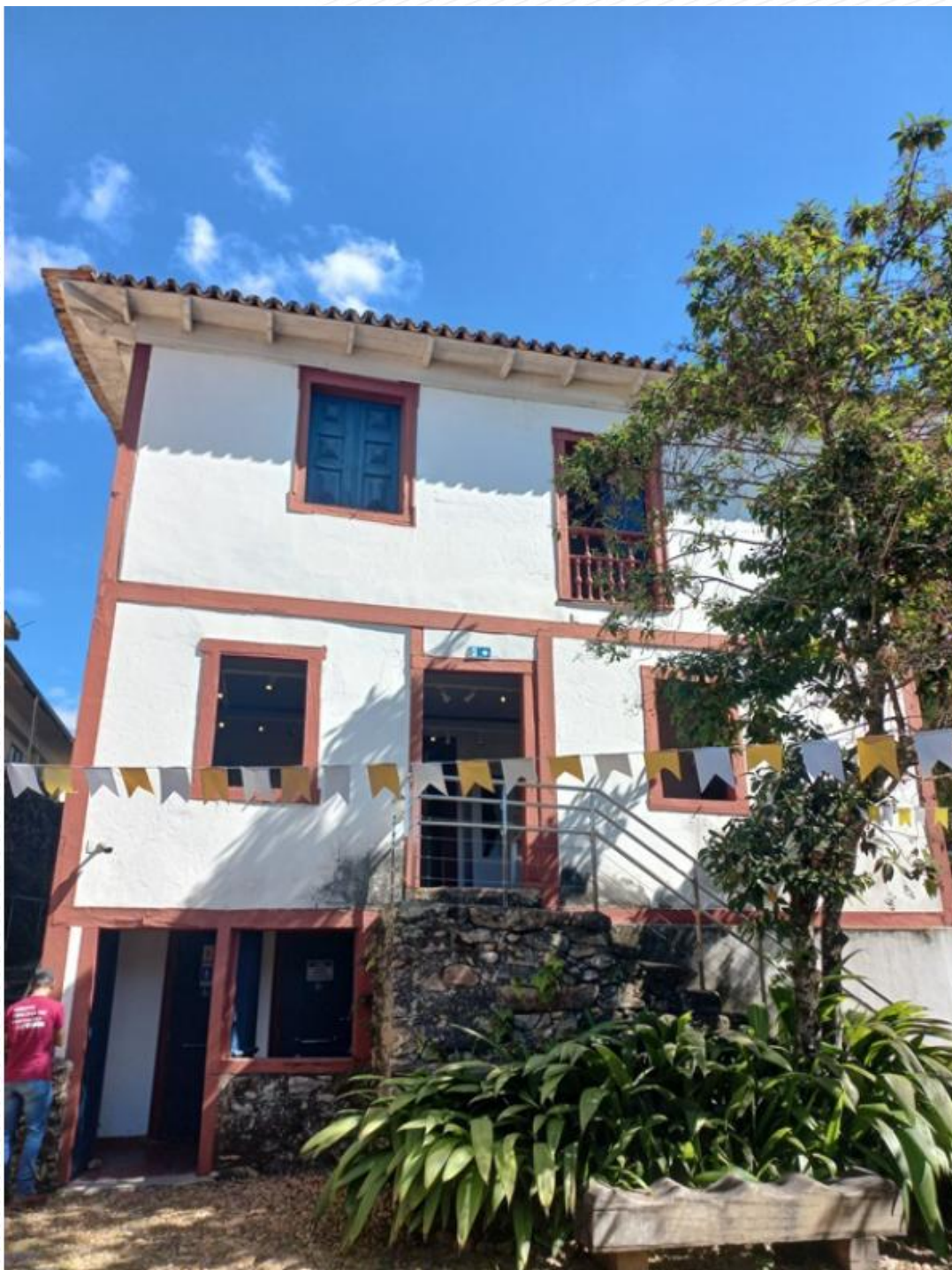
Imagem 03 – Foto em vistoria no dia 20/06/2024 O Fachada Nordeste do Museu Regional de Caeté
