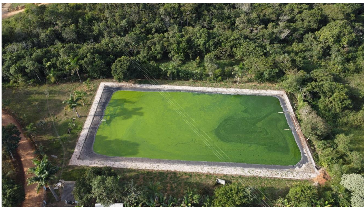
Figura 11: Foto da área da ETE do Distrito de Ouro Fino
