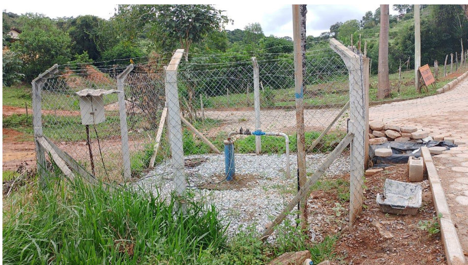
Figura 02: Foto do poço semiartesiano do Distrito de Córregos
