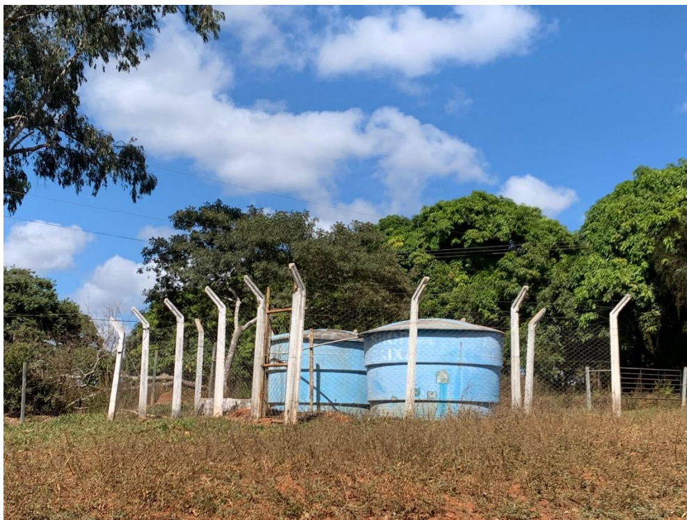
Figura 14: Foto dos reservatórios do Distritos de Capitão Felizardo
