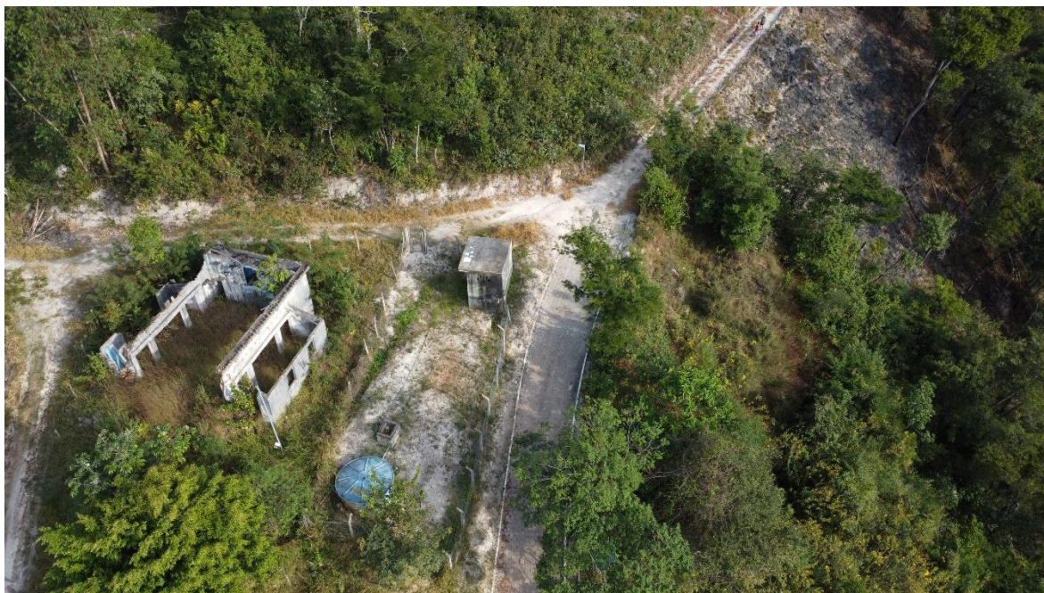
Figura 12: Foto da área do reservatório e abrigo do tratamento de água do Distrito de Ouro Fino
