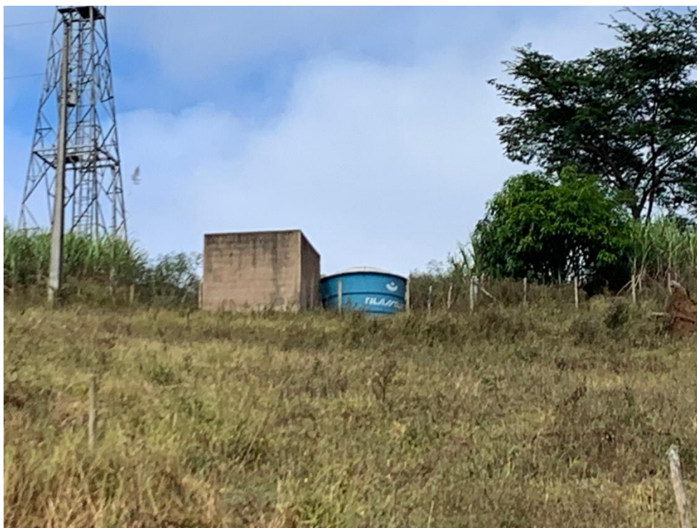
Figura 15: Foto do reservatório e tratamento de água do Distrito de Santo Antônio do Cruzeiro
