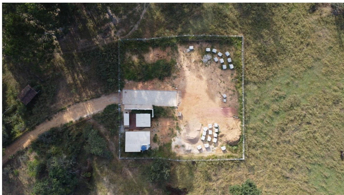
Figura 08: Foto dos reservatórios do Distrito de Santo Antônio do Norte
