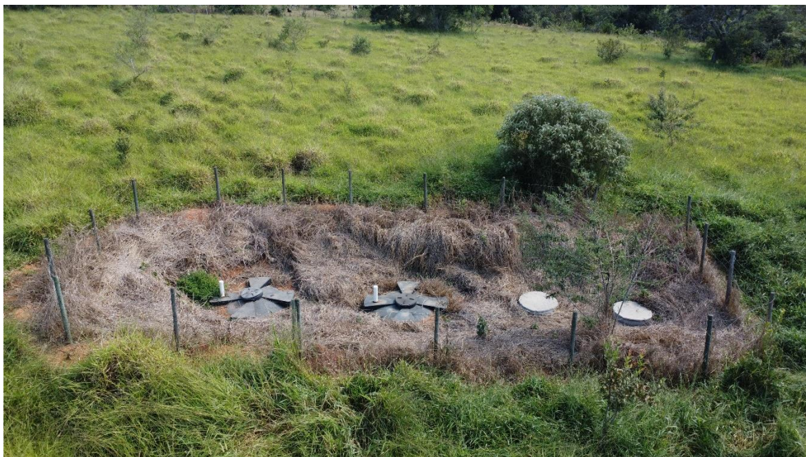
Figura 16: Foto do cercamento da ETE do Distrito de Capitão Felizardo
