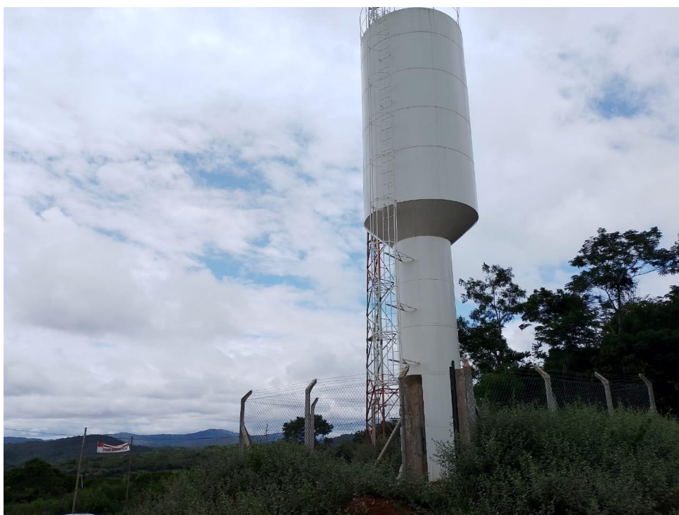
Figura 06: Foto do reservatório metálico do Distrito de Córregos
