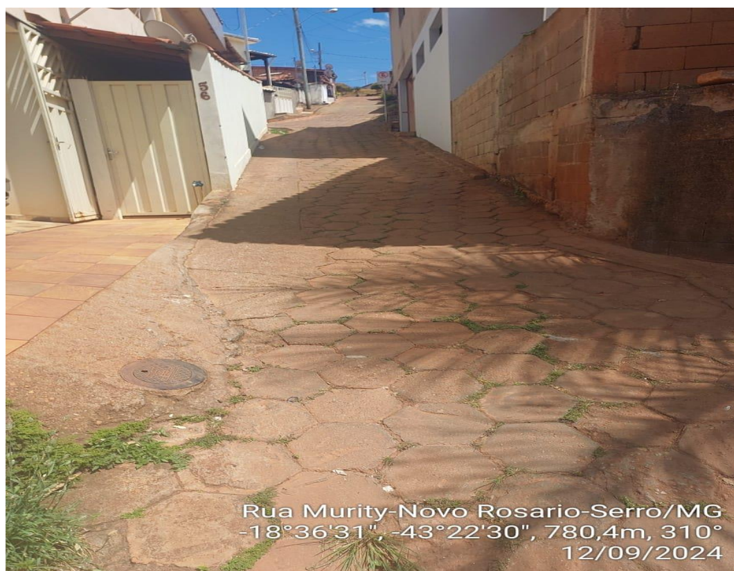
Foto 03: Pavimentação existente na Tv. Murity.
