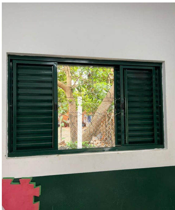
Foto 08 – Sala de aula
