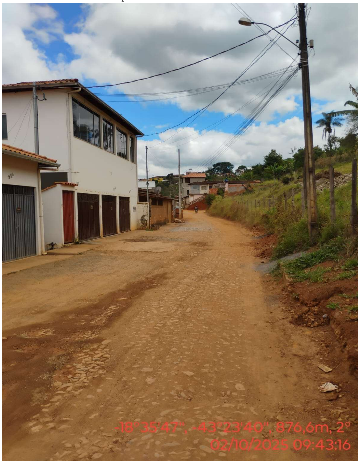
Foto 03: Rua Nossa Senhora Aparecida
