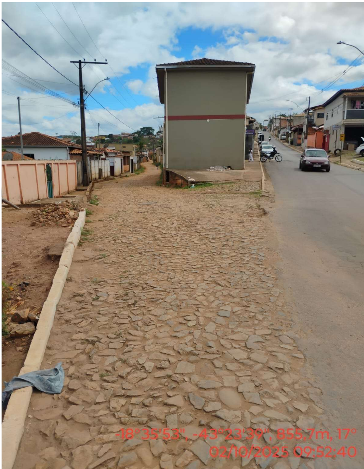
Foto 02: Rua Nossa Senhora Aparecida
