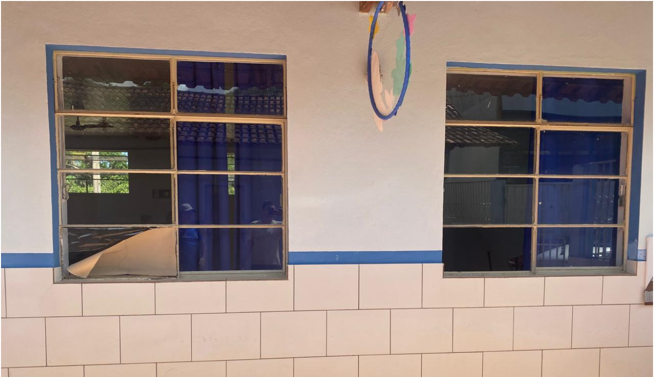
FOTO 9 – VIDROS A SEREM INSTALADOS
