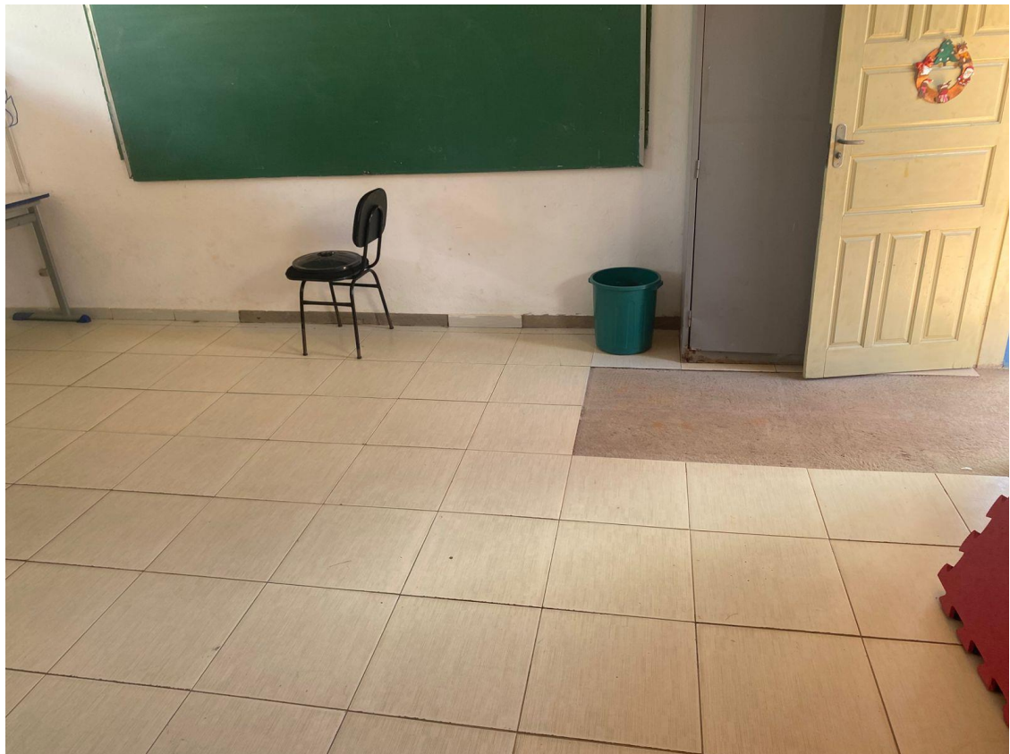
FOTO 16 – SALA 05 (TROCA DE PISO CERÂMICO NO CHÃO E INSTALAÇÃO DE PISO CERÂMICO NAS PAREDES)
