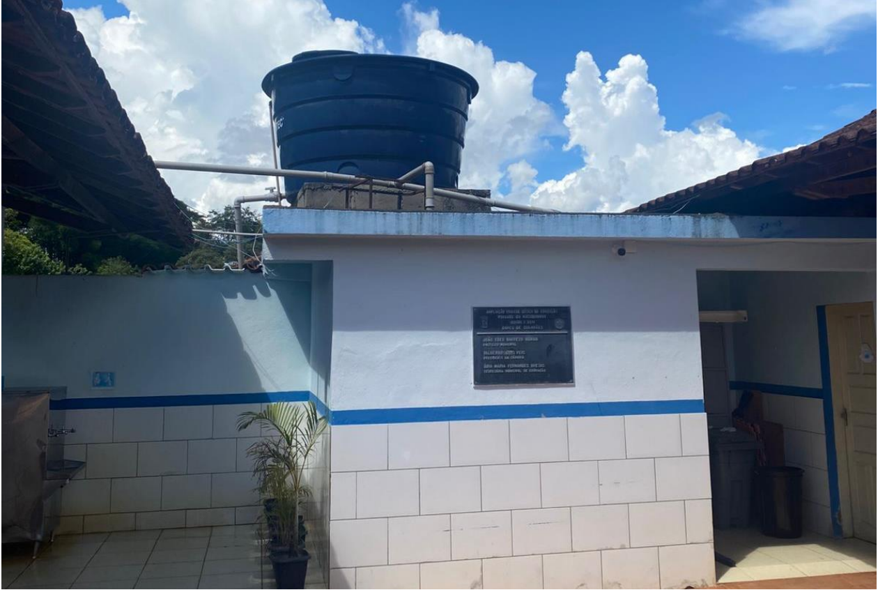
FOTO 18 – FECHAMENTO LATERAL E COBERTURA DA CAIXA D'AGUA
