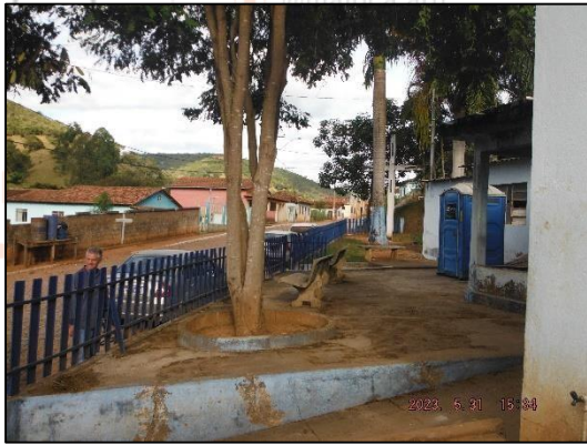
Foto 5: Vista interna da Praça.
