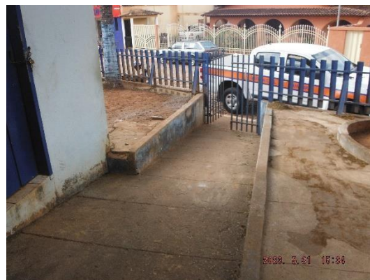
Foto 2: Vista interna da Praça e rampa de acesso existente.
