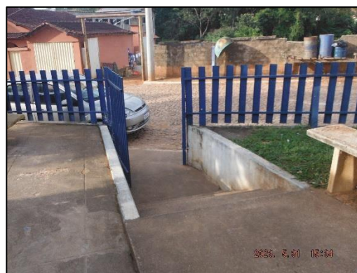
Foto 4: Vista interna da Praça e da escadaria de edificação que deverá ser demolida. Acesso existente.
