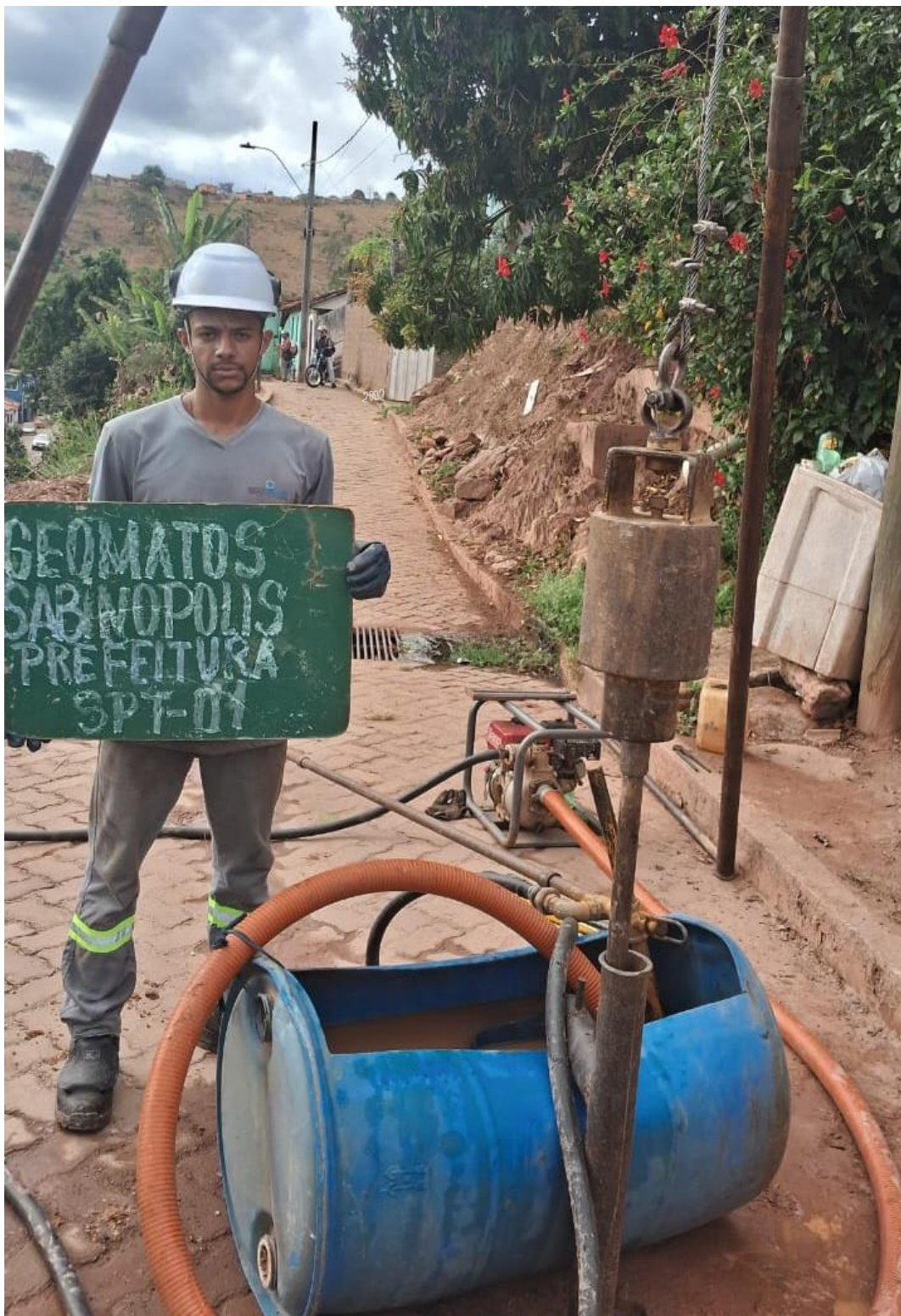
Foto 2 – Execução do furo SPT-01.
