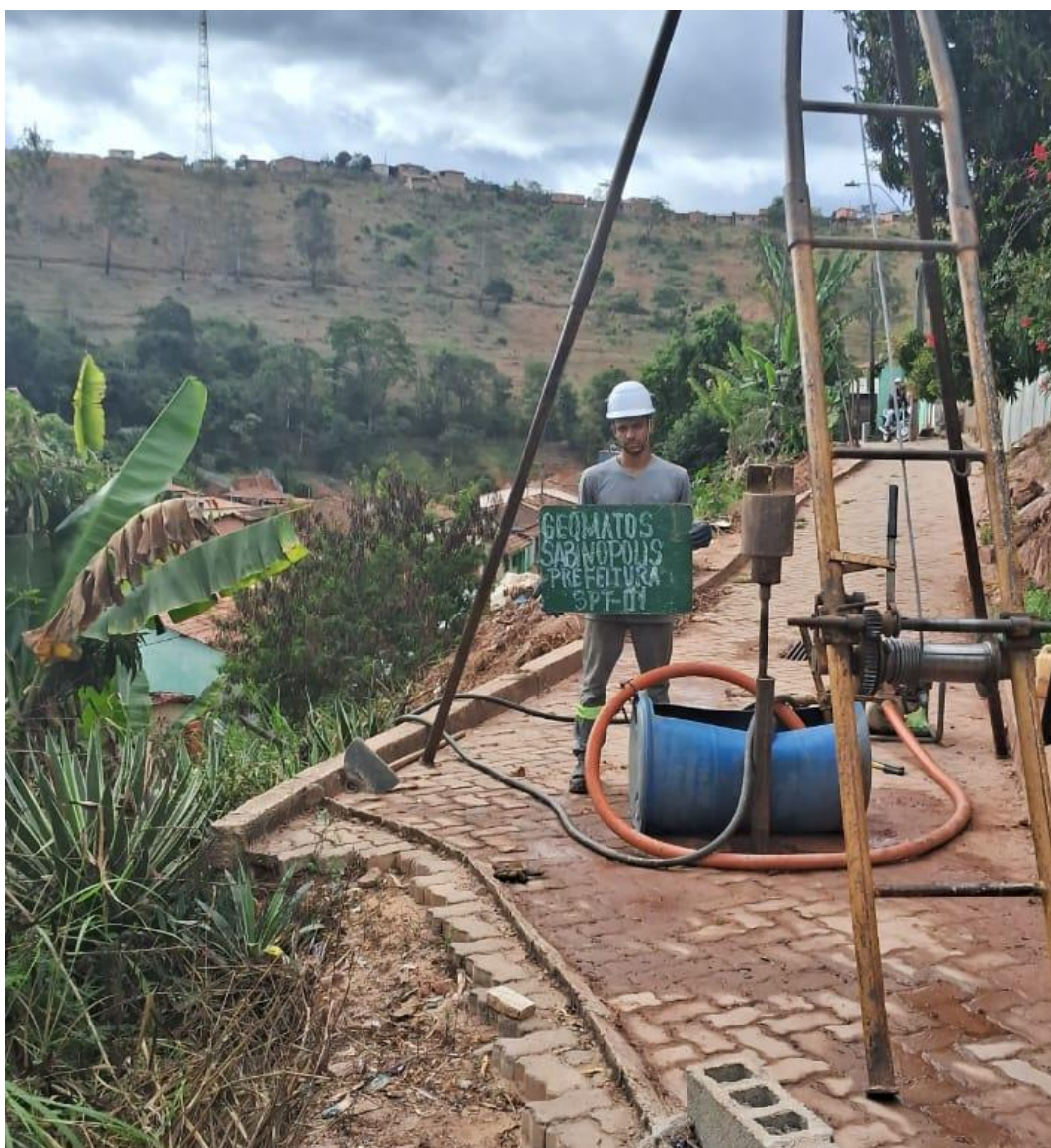
Foto 1 – Execução do furo SPT-01.
