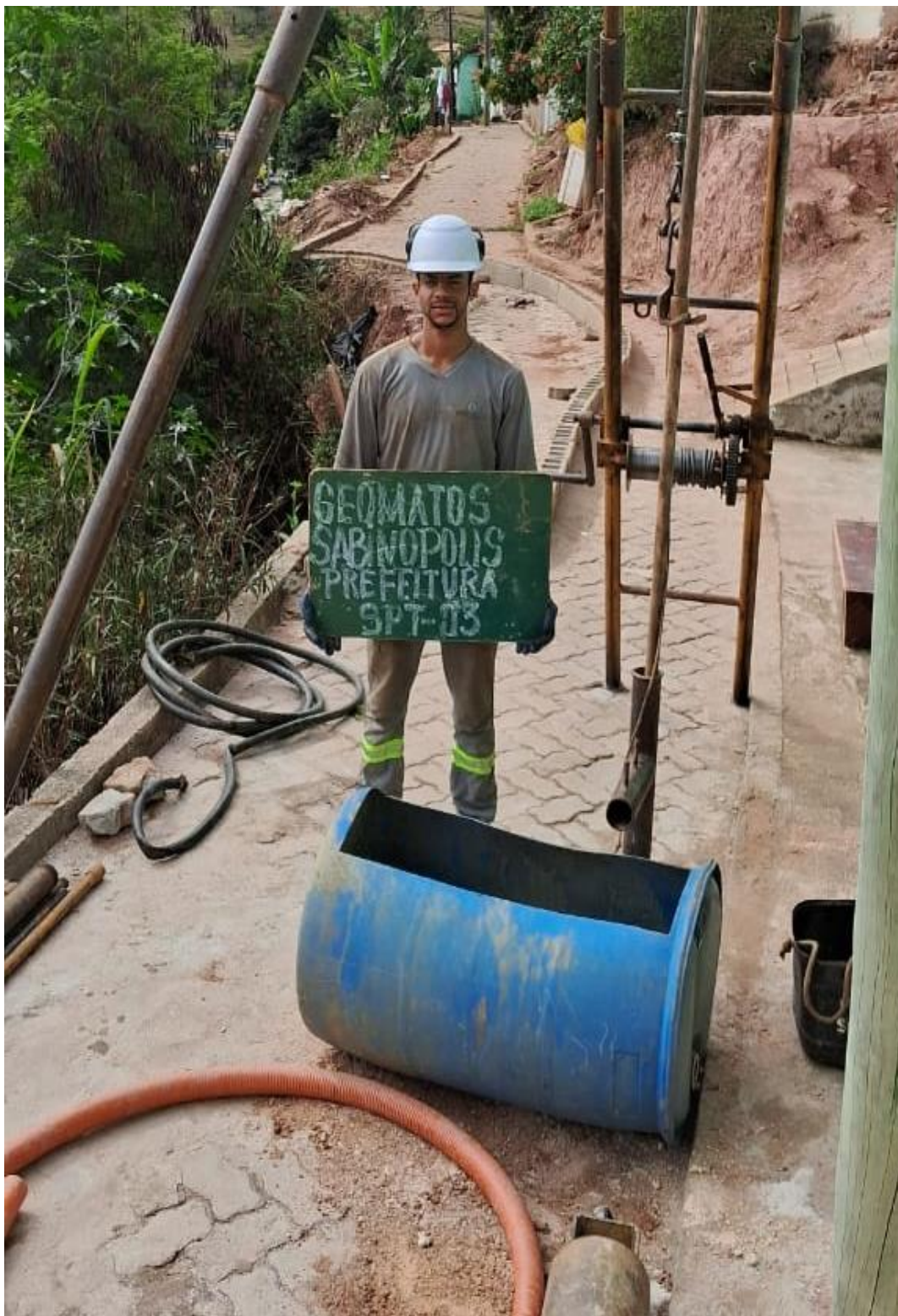
Foto 6 – Execução do furo SPT-03.
