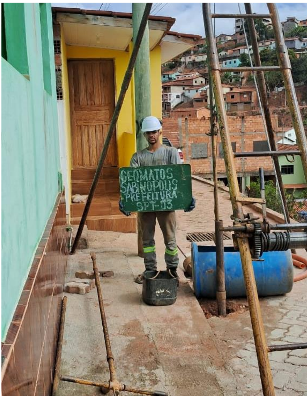
Foto 5 – Execução do furo SPT-03.
