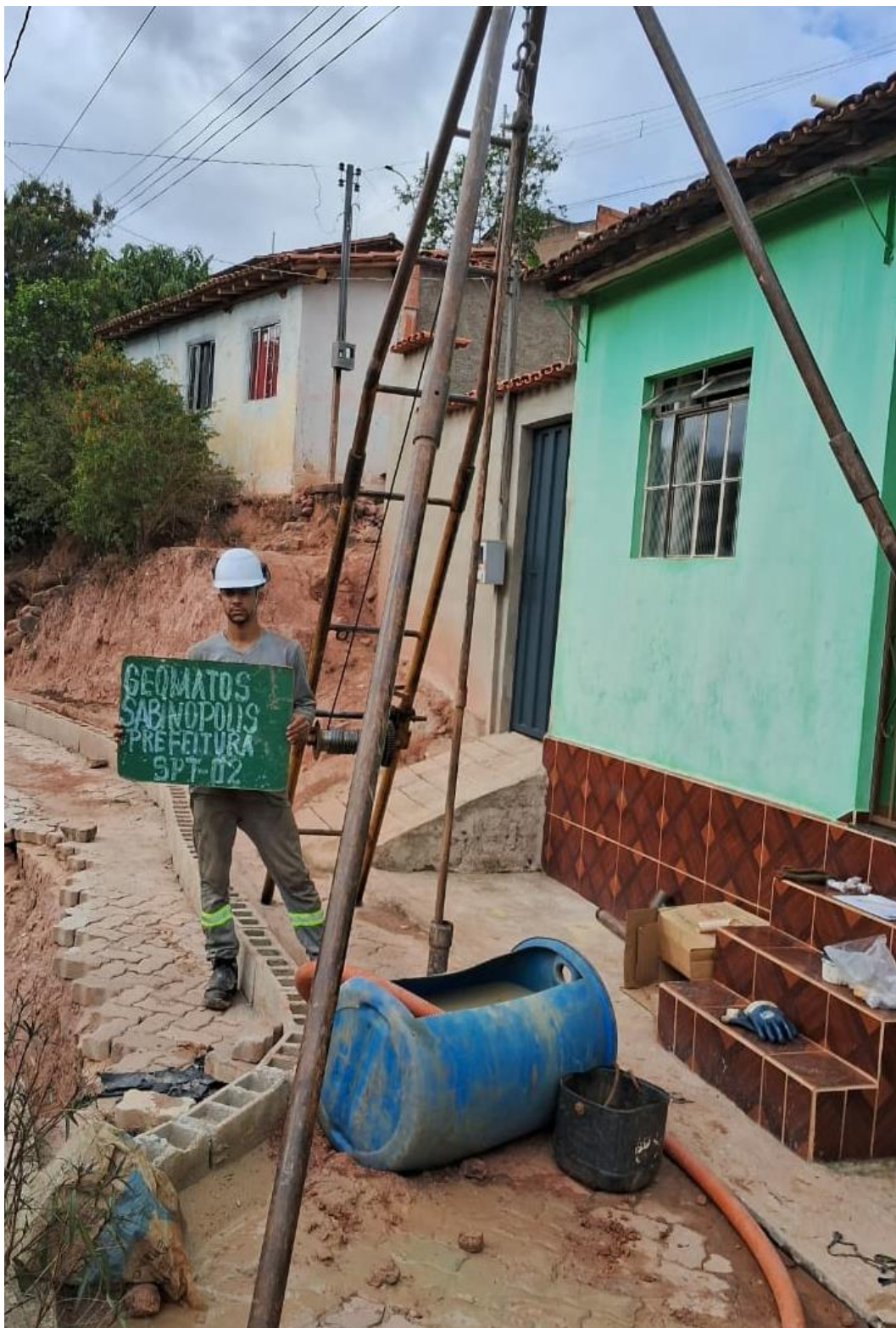
Foto 4 – Execução do furo SPT-02.
