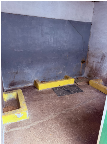
Foto8: Interior das baias.
