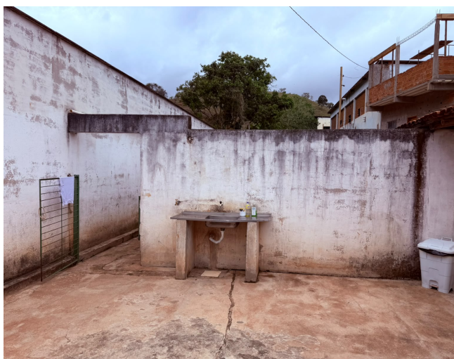
Foto4: Área descoberta em frente ao refeitório e vestiário.
