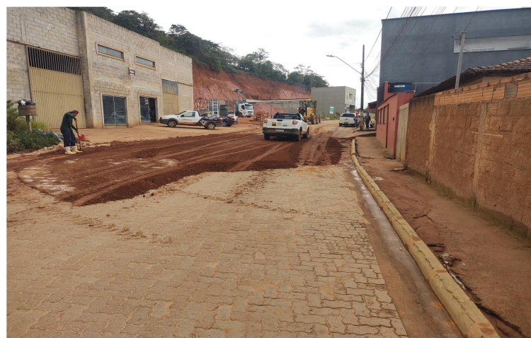
Trecho da Rua Francisco Dias a ser pavimentada
