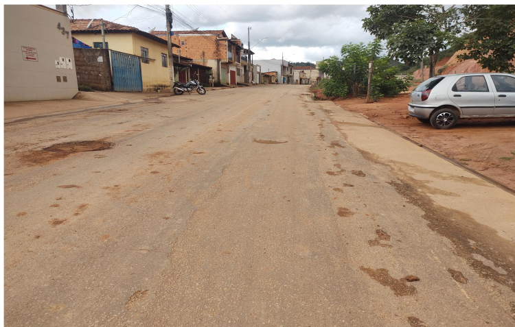
Local onde será o serviço de pavimentação
