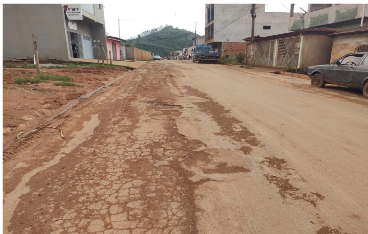
Local onde será o serviço de pavimentação
