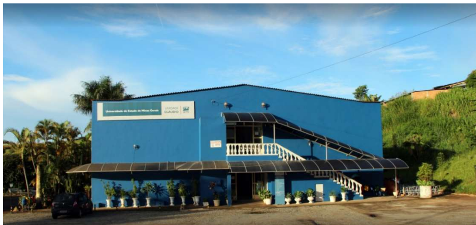
Figura 1: Fachada da edificação principal da Unidade de Cláudio
