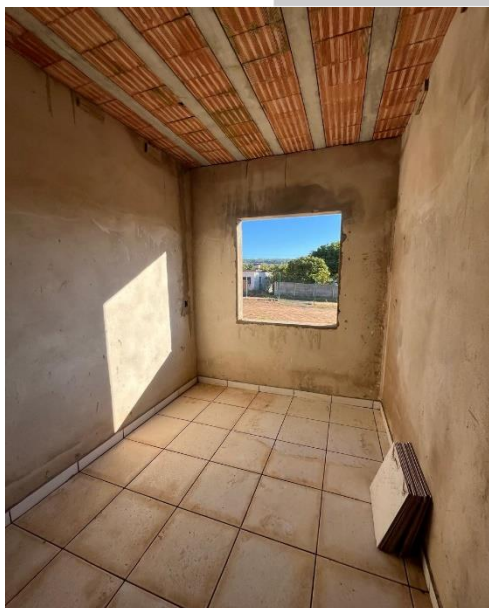
Figura 3- Vista da Sala de Descanso
