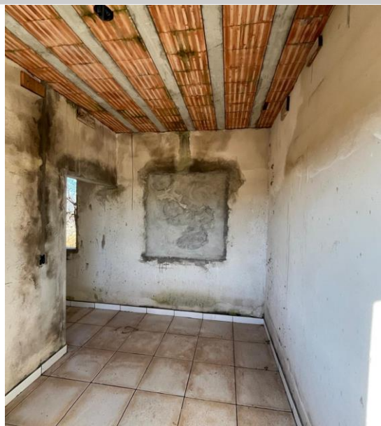
Figura 4- Vista da Sala de Descanso
