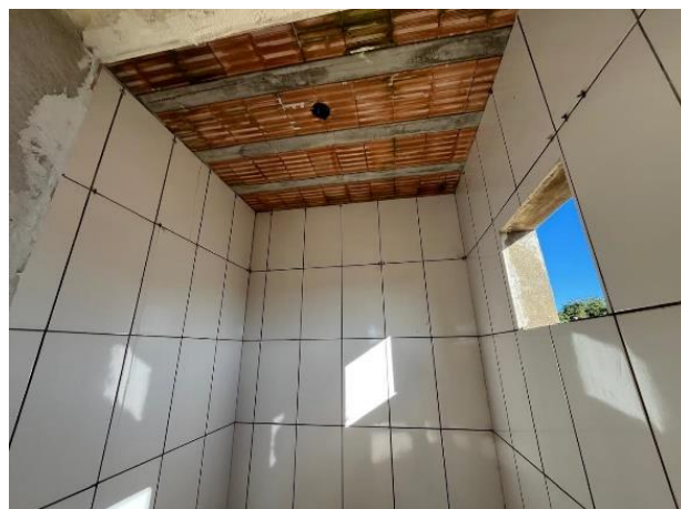
Figura 6- Vista do I.S. P.C.D. Unissex
