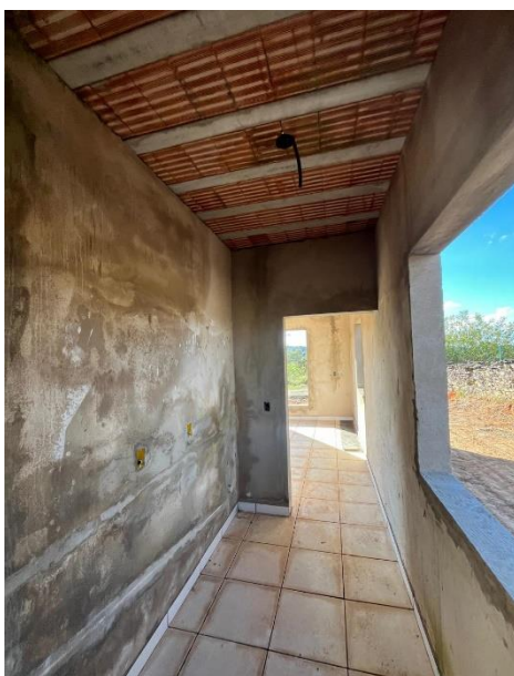
Figura 02- Vista da Sala de Apoio
