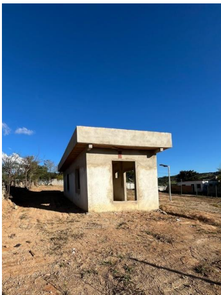
Figura 7- Vista para Área da Varanda
