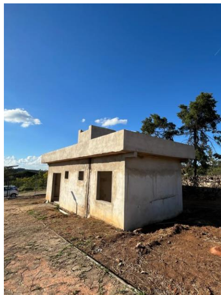
Figura 8 - Vista para Área da Varanda
