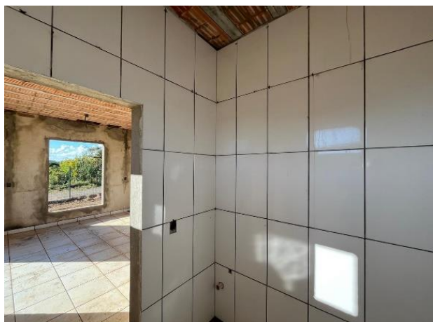
Figura 5- Vista do I.S. P.C.D. Unissex
