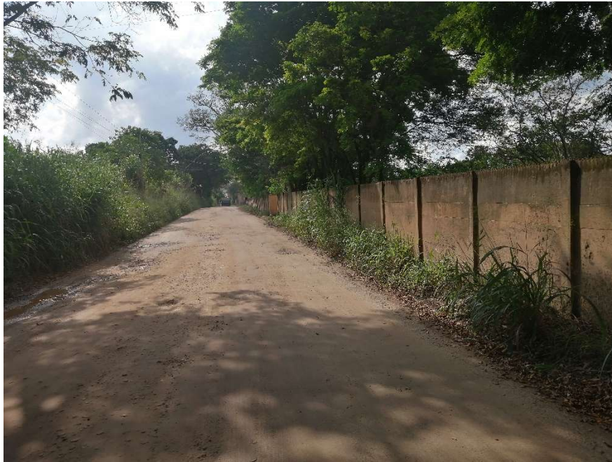
Foto 02: Estrada municipal no povoado de Matinha (Parte do trecho que se pretende asfaltar)
