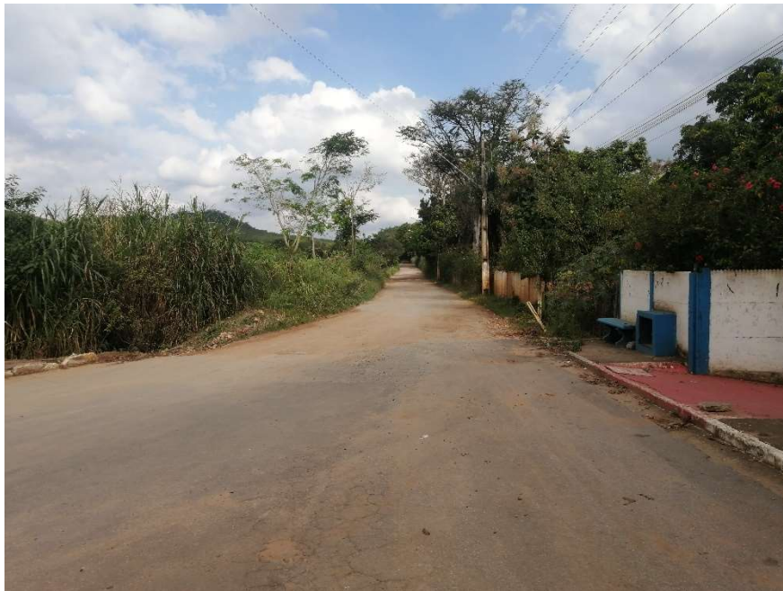
Foto 01: Estrada municipal no povoado de Matinha (Início do trecho que se pretende asfaltar)
