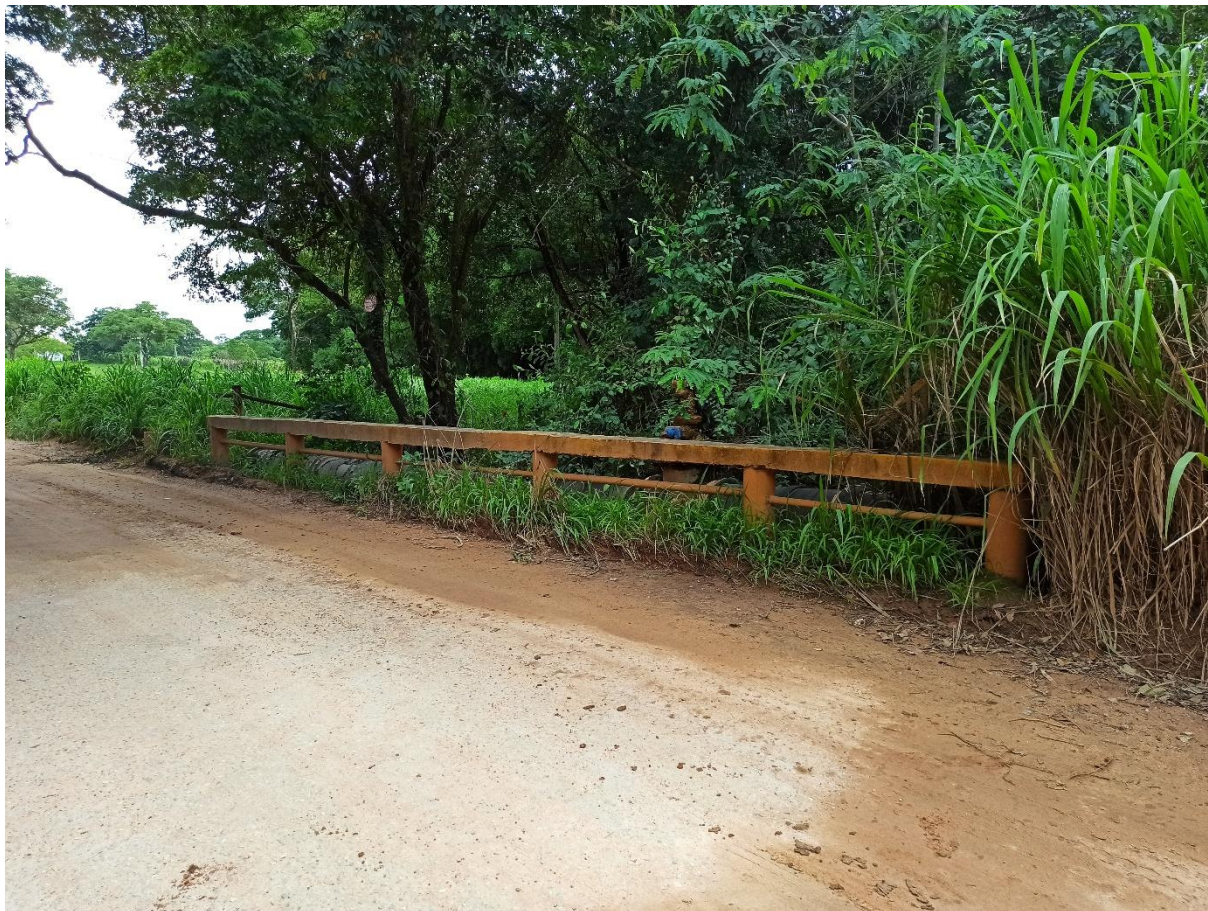
Foto 02: Ponte 2 – Estrada de Bom Jesus do Pará a Córrego do Barro
