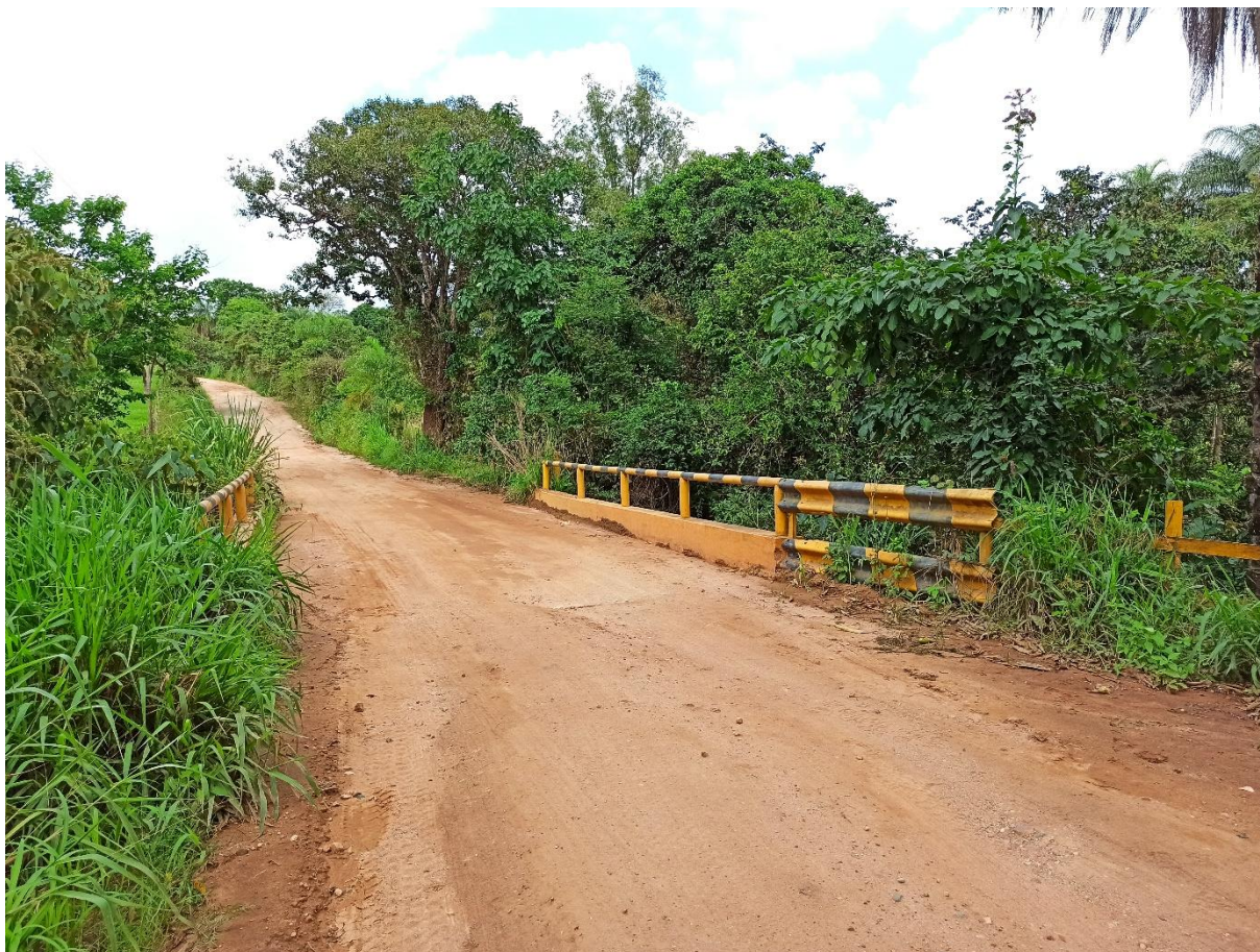
Foto 04: Ponte 4 – Estrada de Bom Jesus do Pará a Córrego do Barro
