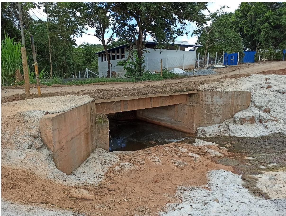
Foto 07: Ponte 7 – Estrada de Bom Jesus do Pará a Córrego do Barro
