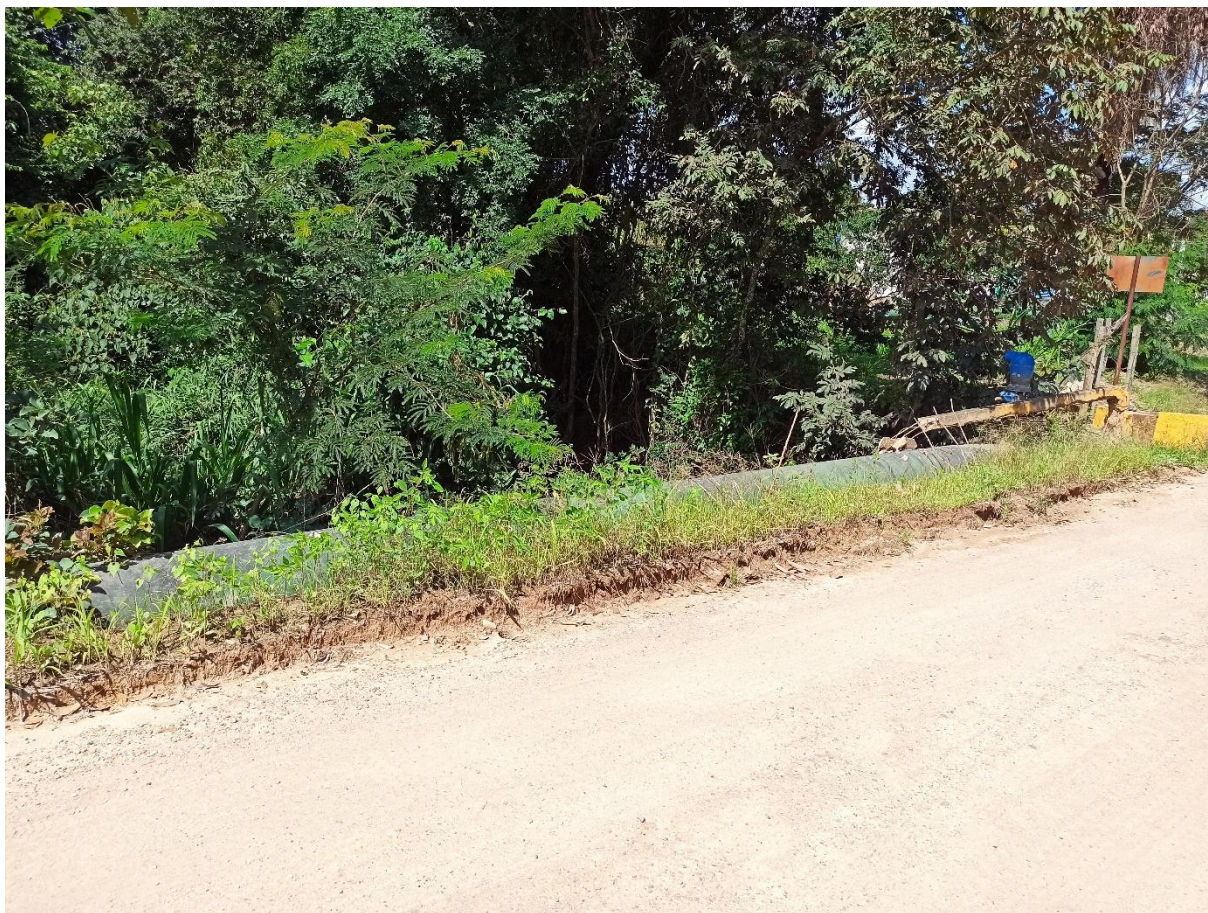
Foto 05: Ponte 5 – Estrada de Bom Jesus do Pará a Córrego do Barro
