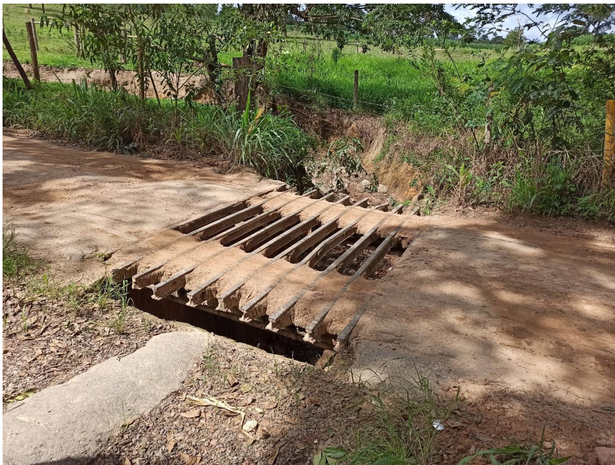
Foto 08: Passagem de gado 1 – Estrada de Bom Jesus do Pará a Córrego do Barro
