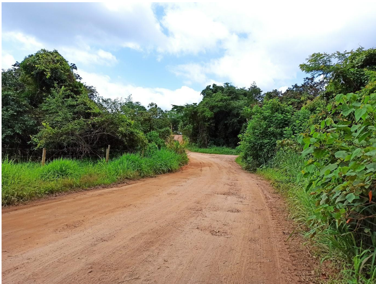
Foto 03: Ponte 3 – Estrada de Bom Jesus do Pará a Córrego do Barro
