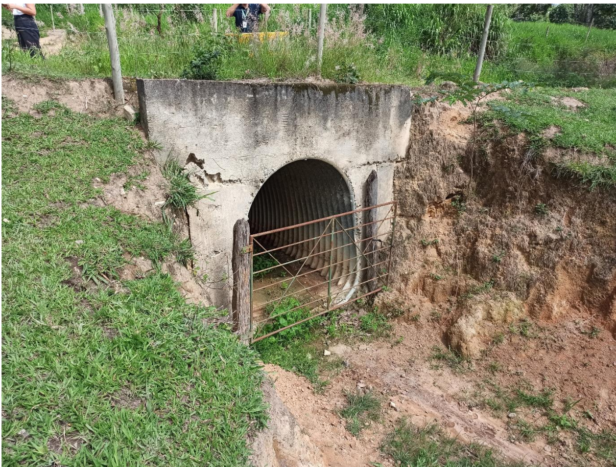
Foto 09: Passagem de gado 2 – Estrada de Bom Jesus do Pará a Córrego do Barro
