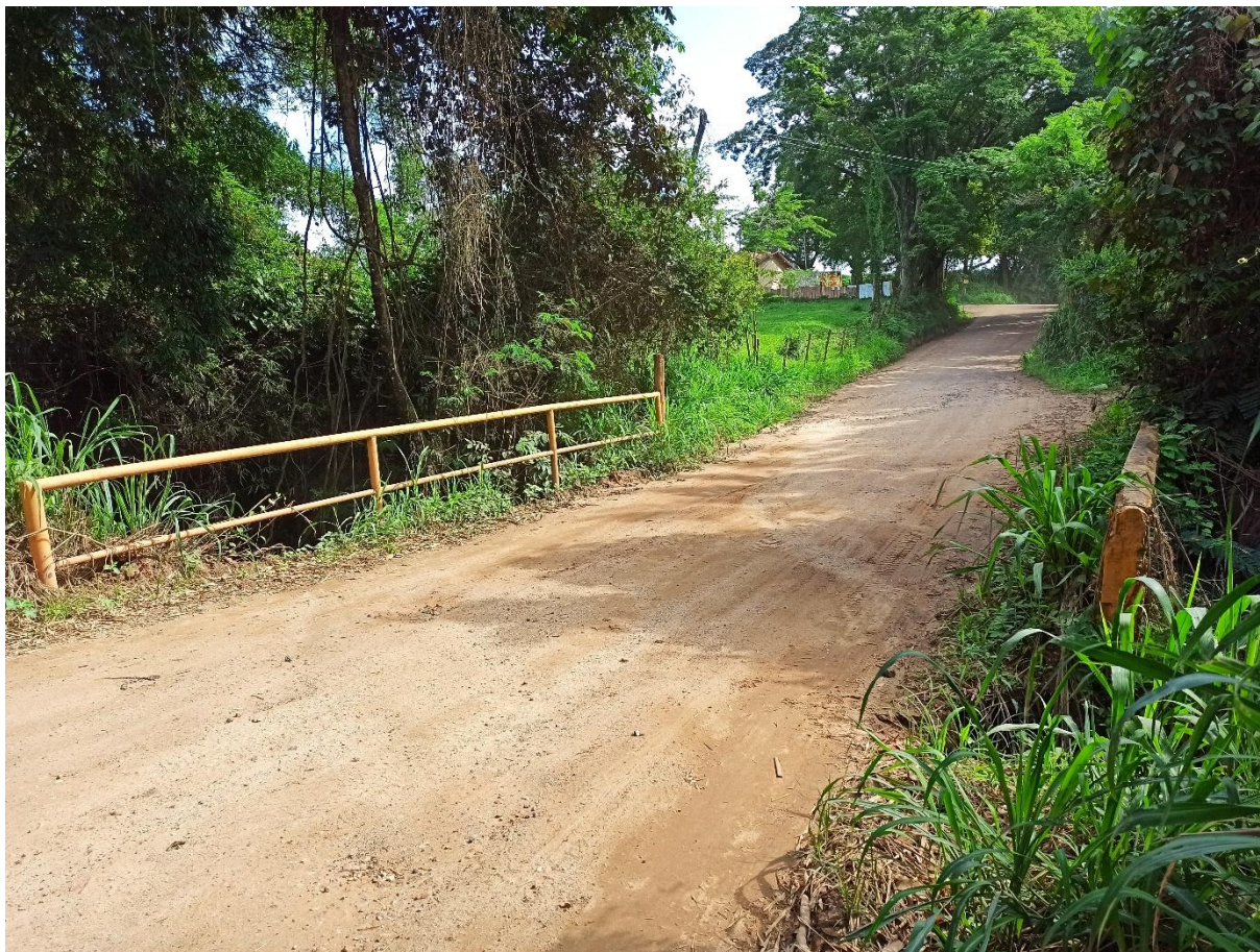
Foto 01: Ponte 1 – Estrada de Bom Jesus do Pará a Córrego do Barro
