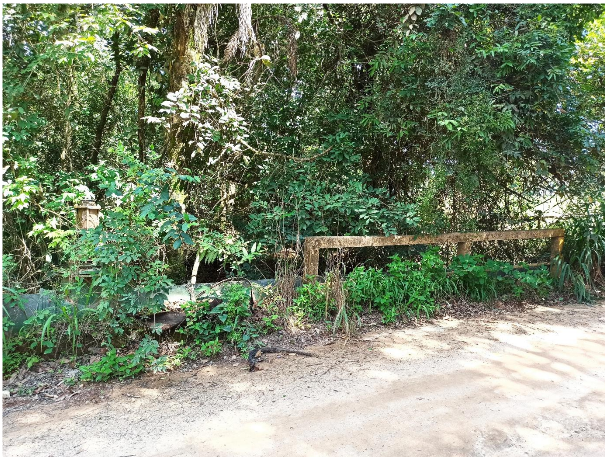
Foto 06: Ponte 6 – Estrada de Bom Jesus do Pará a Córrego do Barro
