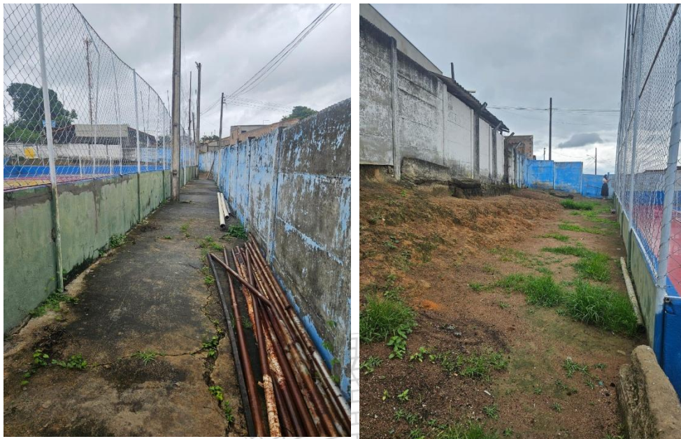
Imagem 02 e 03: Vista da área de intervenção. Fonte: Acervo Prefeitura
