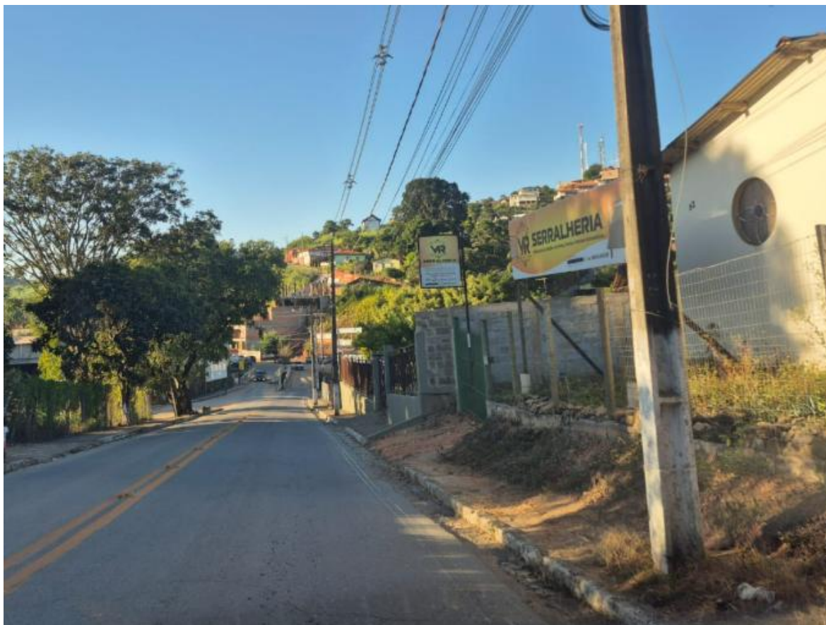
Figura 23: Topografia do trecho 4 (Parte 3).
