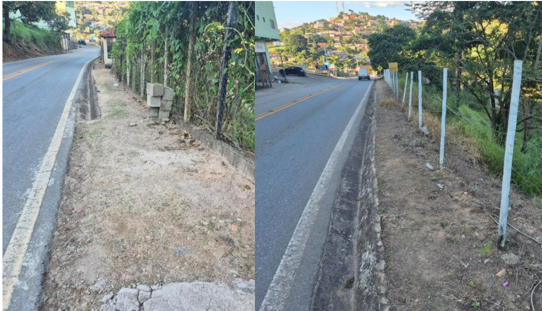
Figuras 20 e 21: Topografia do trecho 4 (Parte 1).
