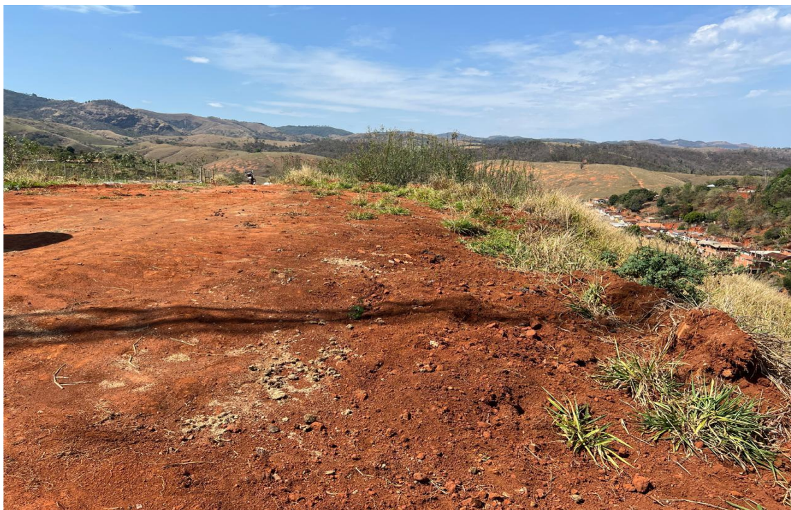
Foto 14_Loteamento das 20 casas populares _Bairro Novo Centro - Quadra 25 – Córrego Novo/MG
