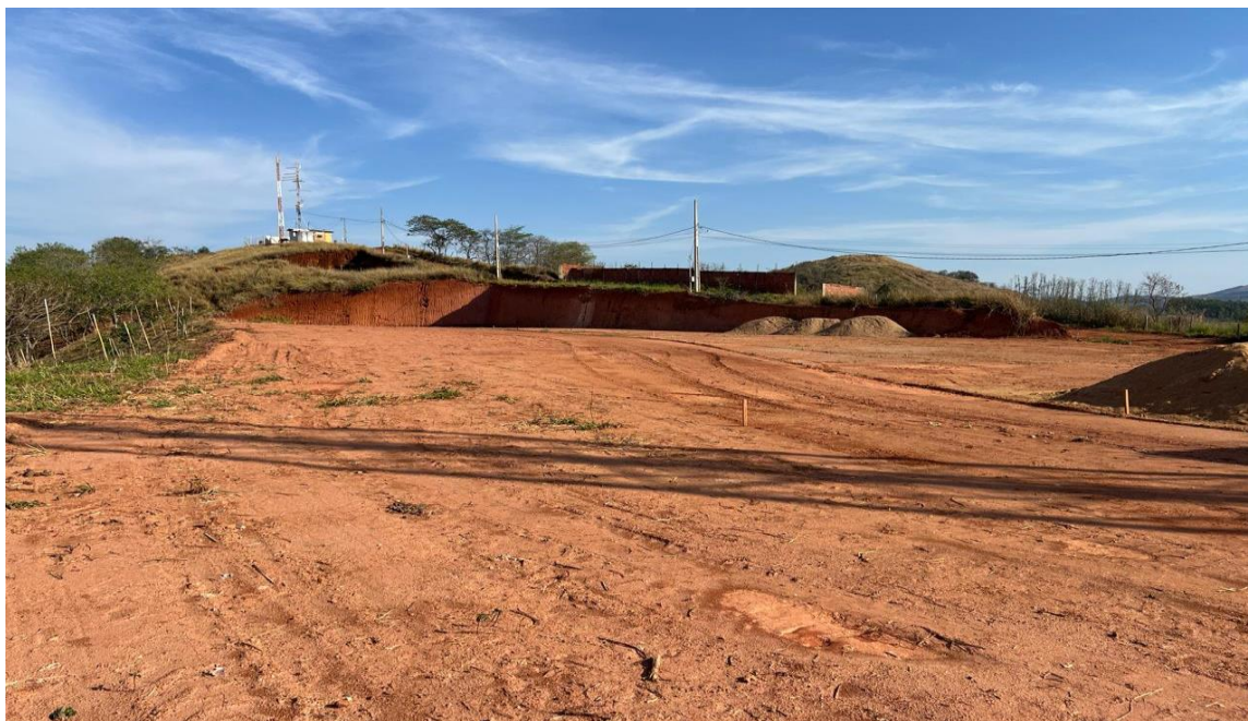
Foto 06_Loteamento das 20 casas populares _Bairro Novo Centro – Córrego Novo/MG
