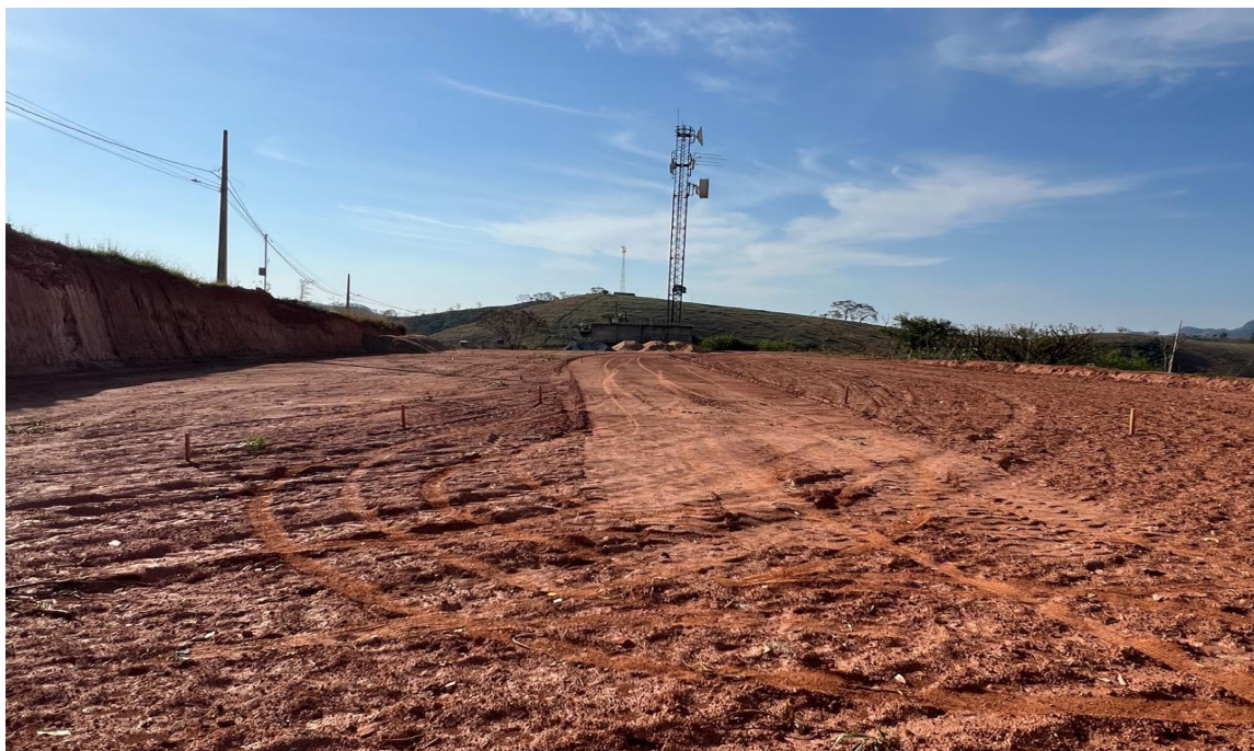
Foto 04_Loteamento das 20 casas populares _Bairro Novo Centro – Córrego Novo/MG
