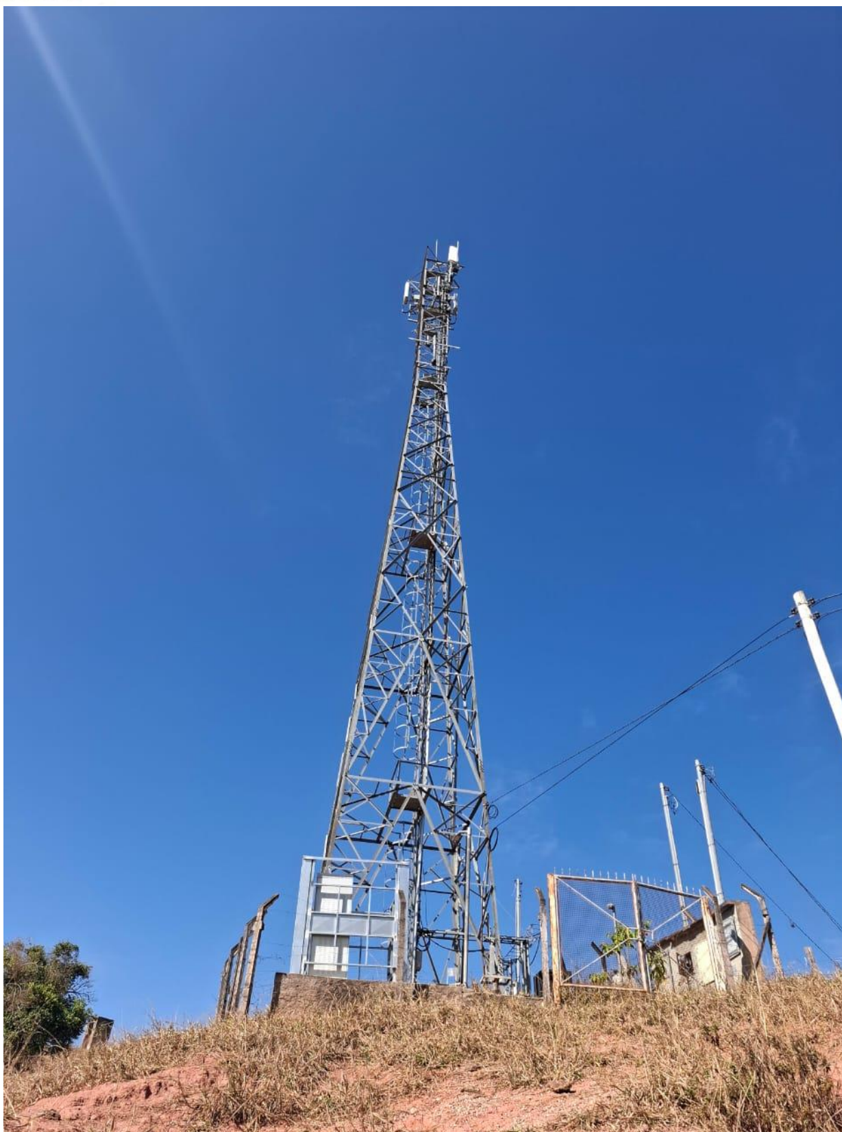
IMAGEM 1: TORRE QUE RECEBERÁ A ILUMINAÇÃO CÊNICA
