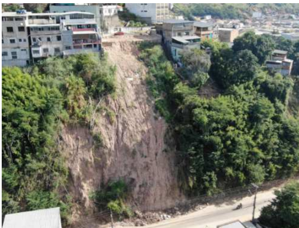
Foto 4: Cicatrizes dos 2 deslizamentos translacionais rasos de grande extensão.
