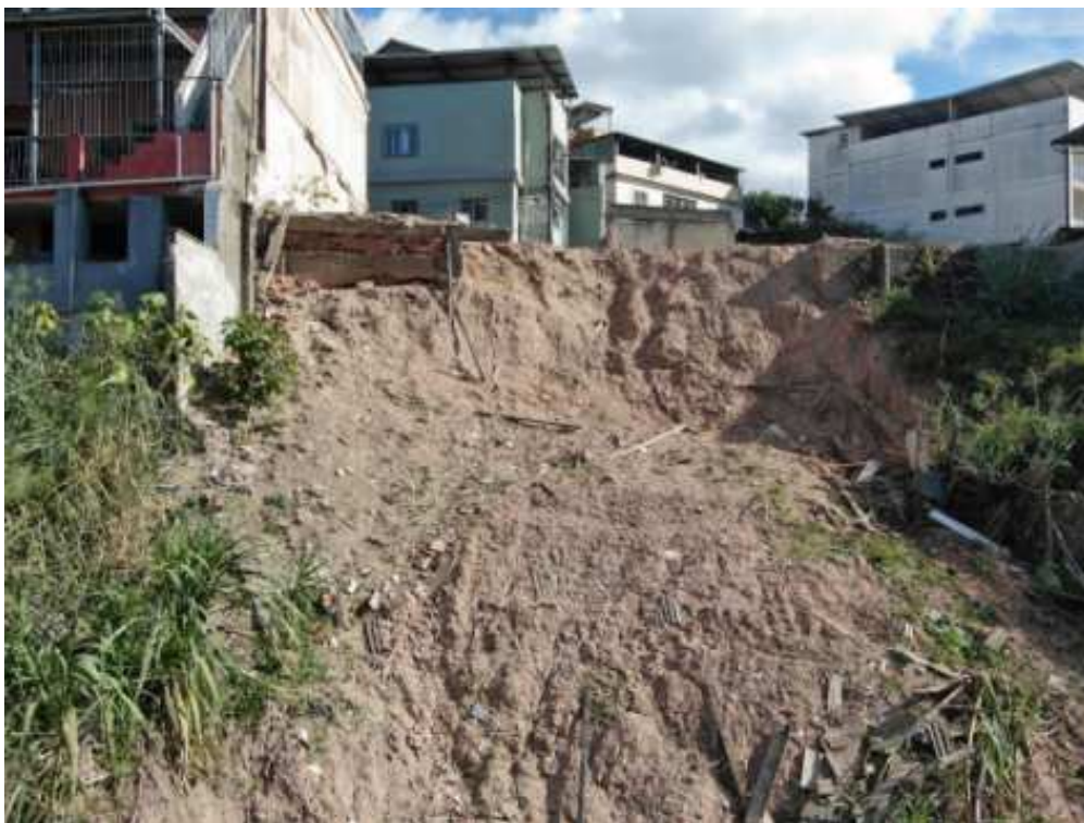
Foto 5: Detalhe da crista da cicatriz da lateral direita hidráulica com início em ruptura circular seguido por deslizamento translacional do solo residual.
