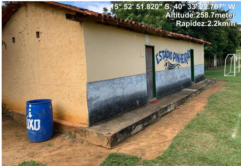
FOTO 04 – ESTÁDIO DE FUTEBOL PINHEIRÃO – ÁREA DESTINADA A CONSTRUÇÃO DE ALAMBRADO;
