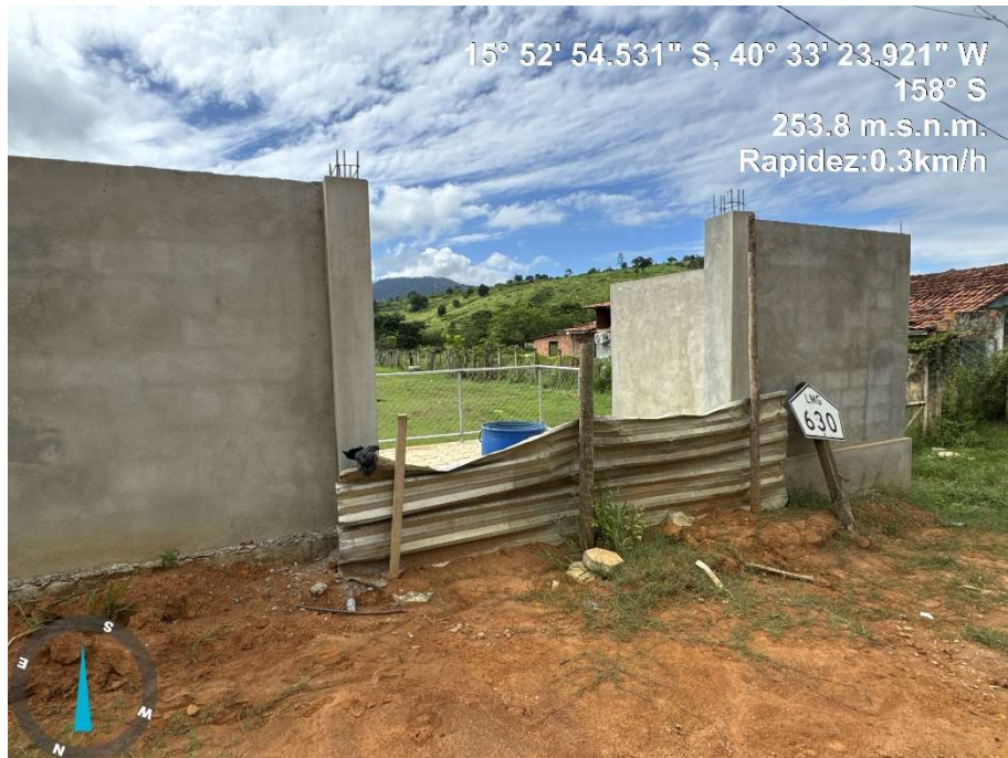
FOTO 08 – ESTÁDIO DE FUTEBOL PINHEIRÃO – ÁREA DESTINADA A INSTALAÇÃO DE PORTÃO;
