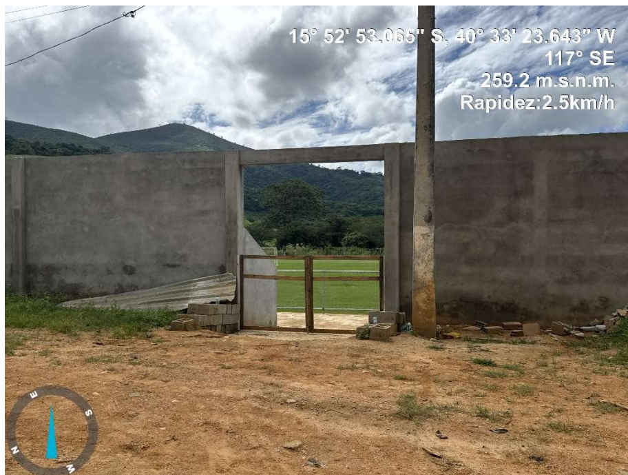
FOTO 09 – ESTÁDIO DE FUTEBOL PINHEIRÃO – ÁREA DESTINADA A INSTALAÇÃO DE PORTÃO;
