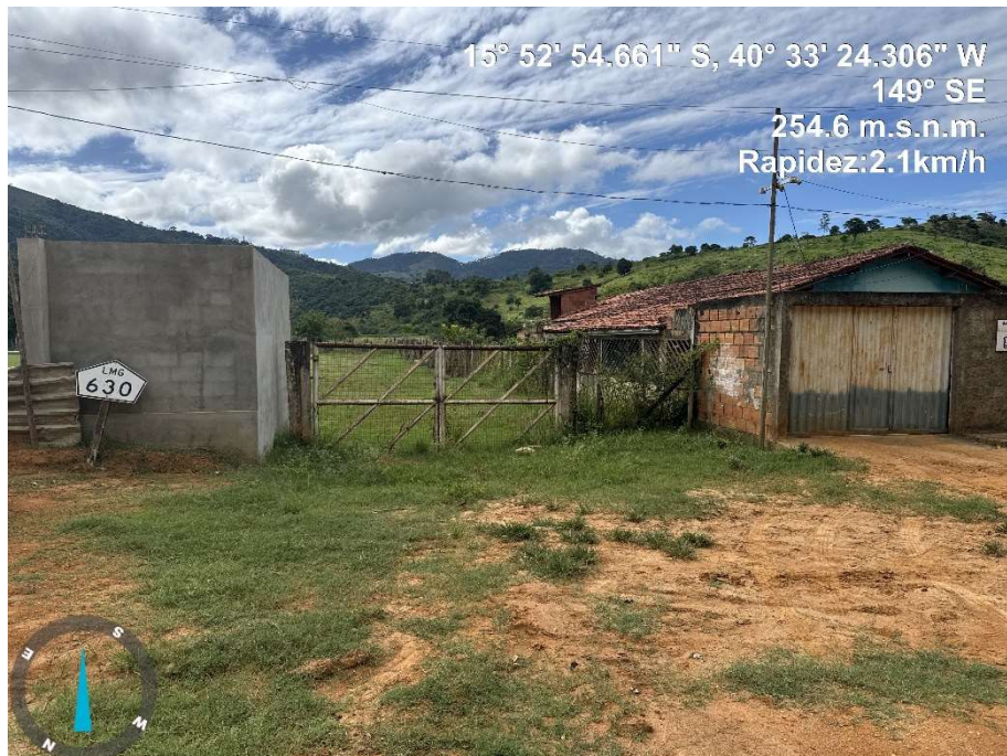
FOTO 07 – ESTÁDIO DE FUTEBOL PINHEIRÃO – ÁREA DESTINADA A CONSTRUÇÃO DE MURO DE FECHAMENTO E PORTÃO;
