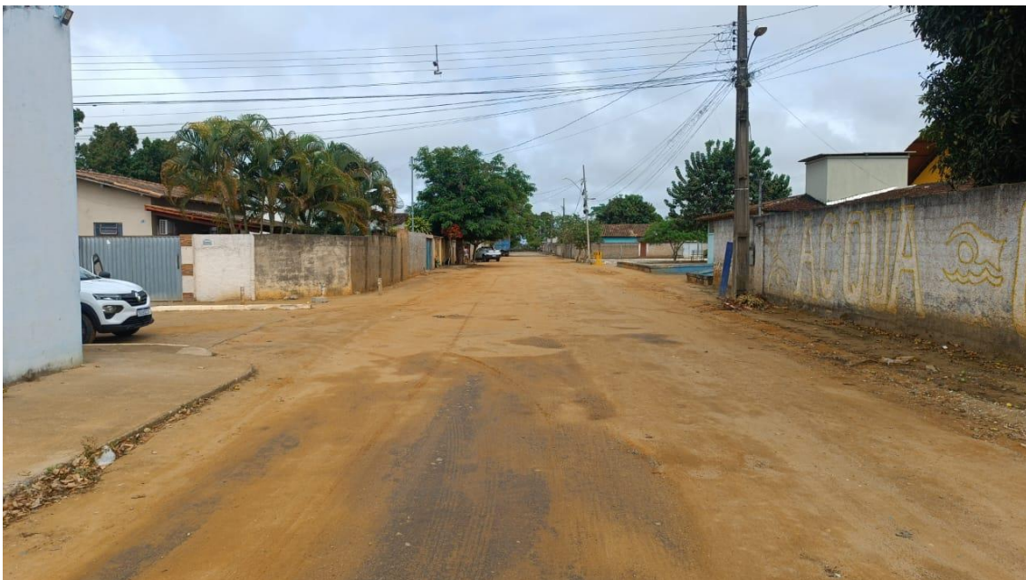
Imagem 8 – Rua Rio Peruípe
