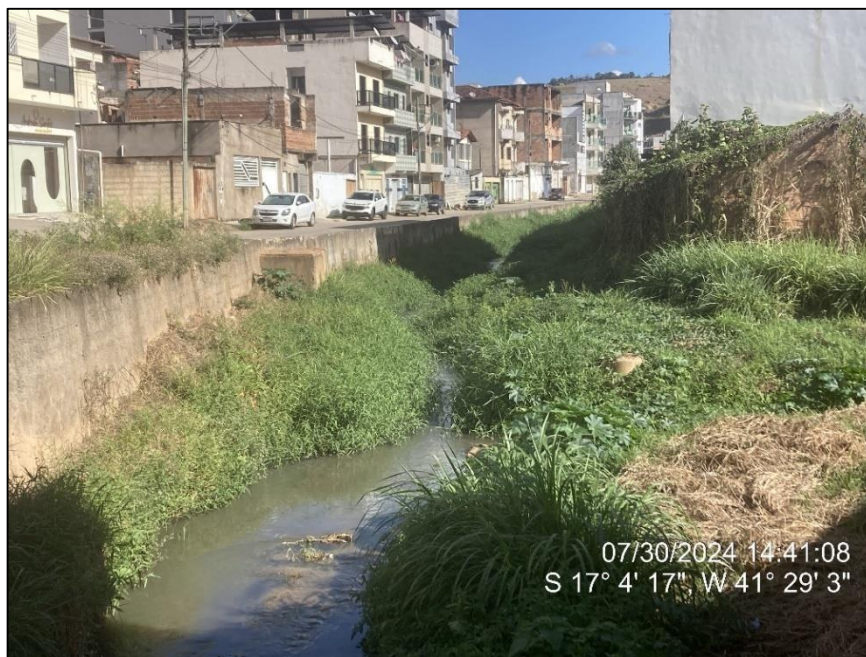
Figura 31 - Trecho de encontro do córrego Água Vermelha e ribeirão São José, onde a travessia foi levada pela força da água durante evento de chuva intensa.
