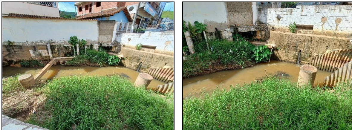
Figura 27 - Interceptores ao redor do ribeirão São João e ligação clandestina de esgoto (Travessia da Avenida Minas Gerais).
