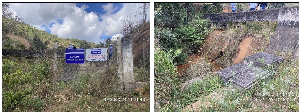
Figura 7 - Barragem de concreto - captação superficial no córrego Boa Vista.
