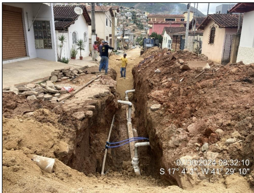
Figura 30 - Trecho que será pavimentado e estão sendo realizadas obras de adequação da rede de esgoto.
