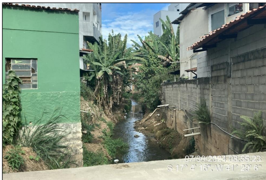
Figura 28 - Pontos com ligações clandestinas de esgoto no ribeirão São João (Travessia da Avenida MG).
