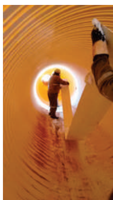
Fase 1: Instalação da luva *Medir e cortar o comprimento da luva e testar.
