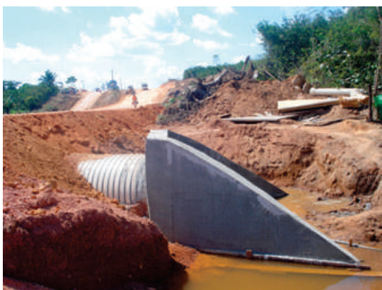
ALAS (Bocas): Nas extremidades das tubulações é indispensável a instalação de alas, seja em concreto ou outro material.
