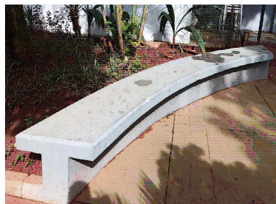
BANCO DE ALVENARIA E CONCRETO
