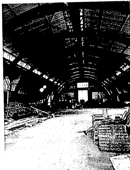
Figura 12: O interior é composto por um sistema estrutural de arcos metálicos treliçados, dispostos de forma seriada para vencer o vão livre e suportar a carga. A cobertura é realizada com telhas metálicas corrugadas, que acompanham o formato do arco. O piso é de cimento polido. O fechamento lateral superior inclui painéis de material translúcido (policarbonato ou fibra) instalados nas aberturas para garantir a iluminação natural.
