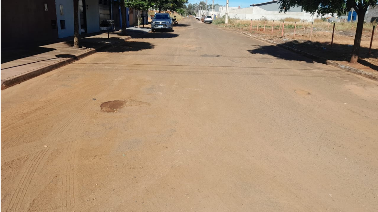
FIGURA 29: Rua Sebastião Rodrigues de Oliveira
