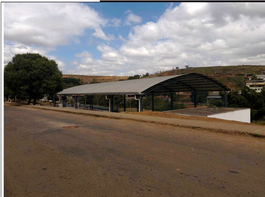
Descrição: Foto 05 10 de agosto de 2025 23k 704876,40m E 7617021,49m S O Centro de Convivência ficará no gramado atrás da quadra existente
