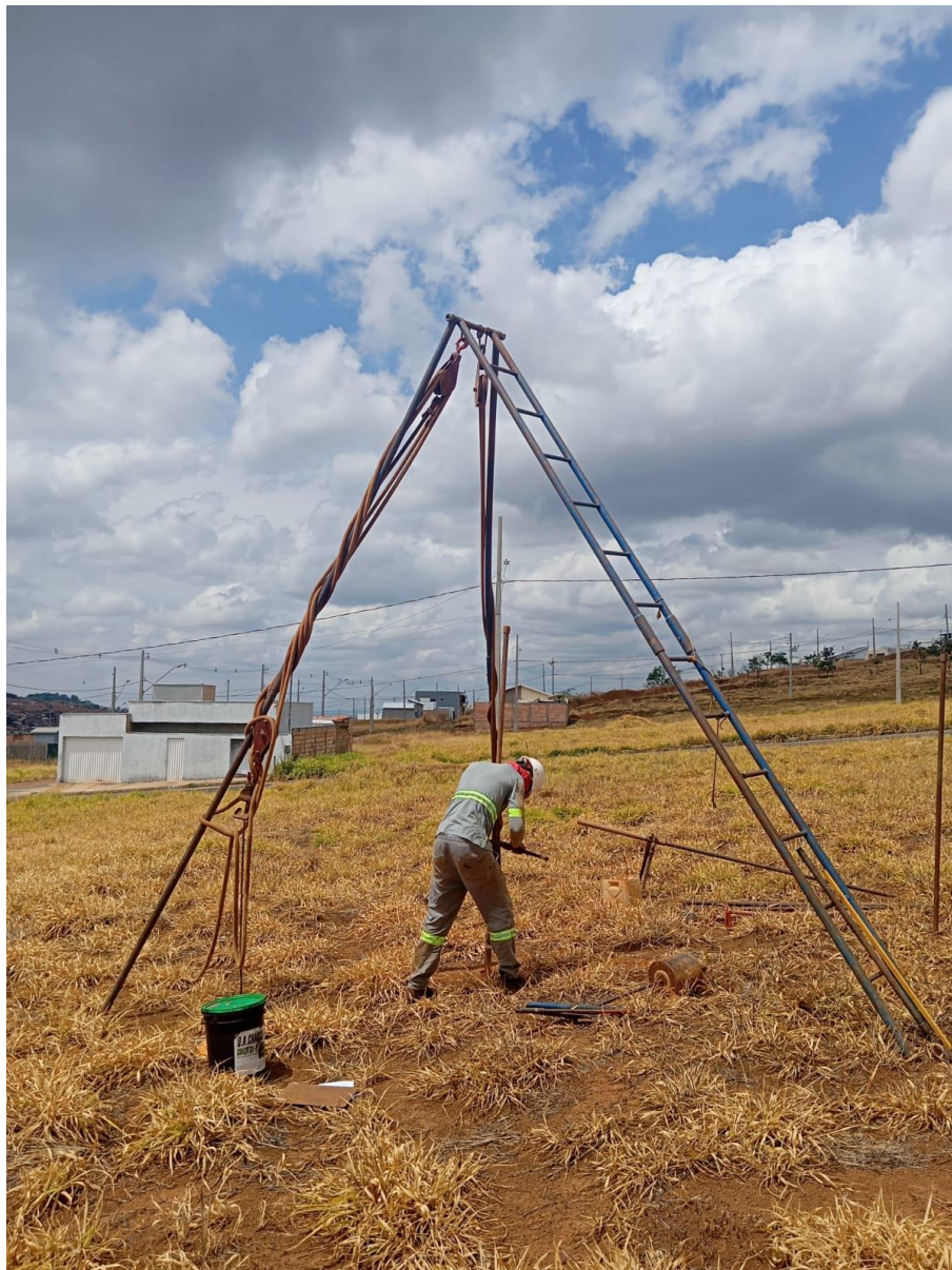
Instalação do furo SP-02
