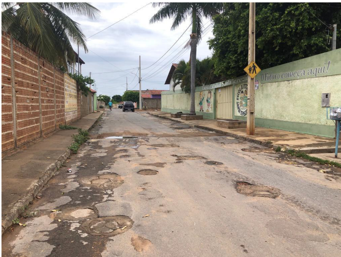
Imagem 06 - Travessa São Domingos, bairro São Domingos
