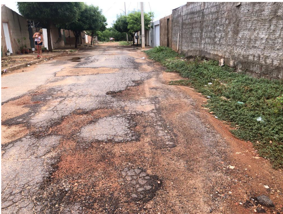
Imagem 09 - Rua Capitão José Valentino, bairro São Domingos.
