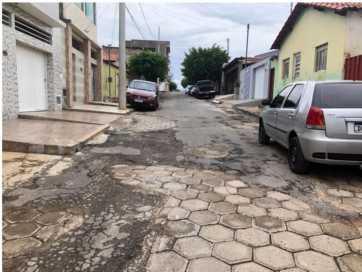
Imagem 05 - Rua São Domingos, bairro São Domingos.
