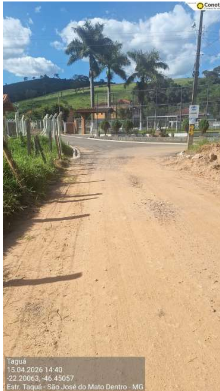
Vista 1 - Trecho a ser asfaltado - Etapa 1
