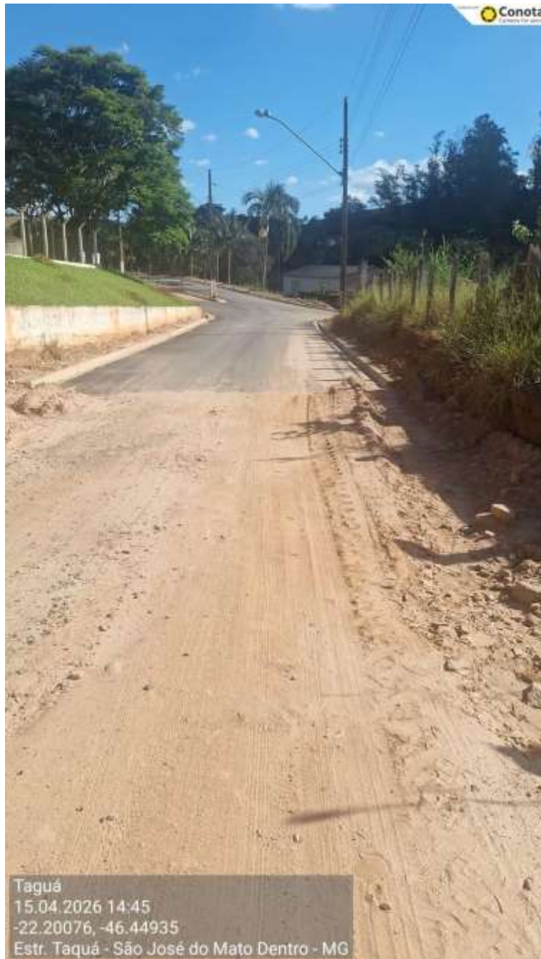
Vista 3 – trecho a ser asfaltado – Etapa 2
