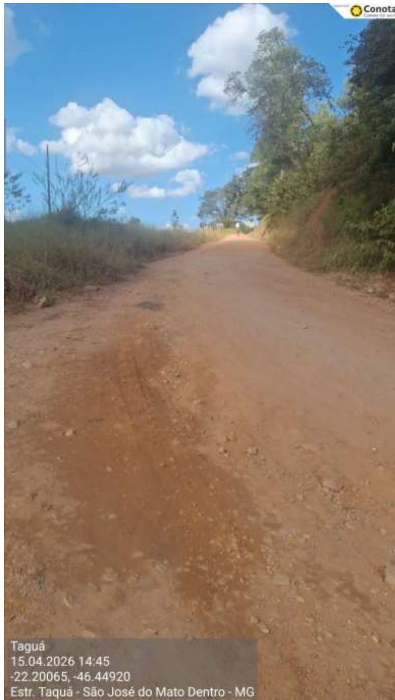
Vista 4 – trecho a ser asfaltado – Etapa 2
