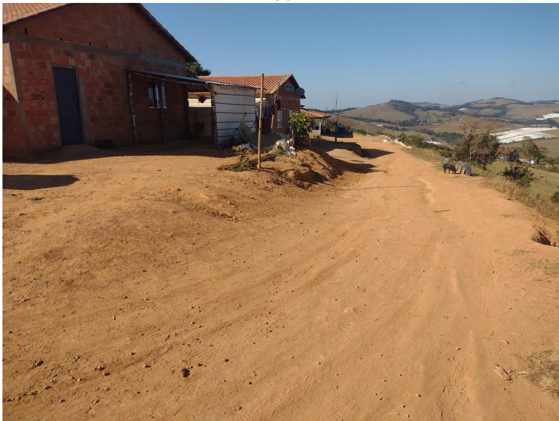
FOTO 03 – LOCAL ONDE SERÁ EXECUTADA A REDE DE ABASTECIMENTO DE ÁGUA
