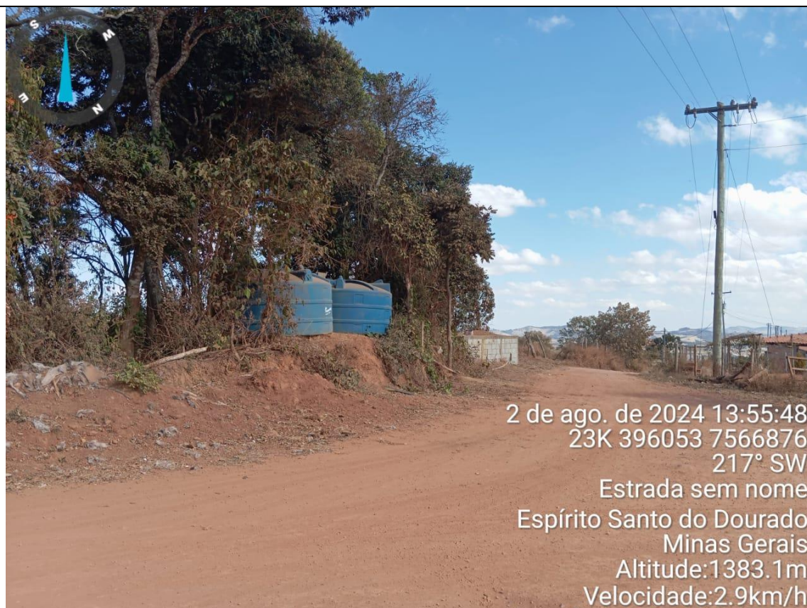
FOTO 01 – PONTO PARA INSTALAÇÃO DO NOVO RESERVATÓRIO
