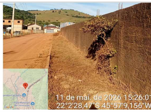
LADO ESQUERDO DA VIA, ONDE TERÁ CALÇADA -22.2'28,47"S -45°57'9,156"W
