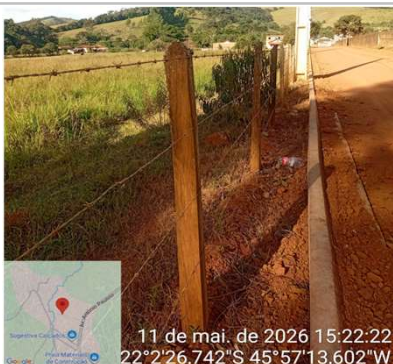
LADO DIREITO DA VIA, ONDE NÃO TERÁ CALÇADA -22.2'26,742"S -45°57'13,602"W
