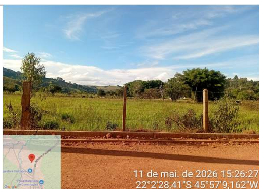
SARJETAS E MEIO-FIO EXISTENTES -22.2'28,41"S -45°57'9,162"W
