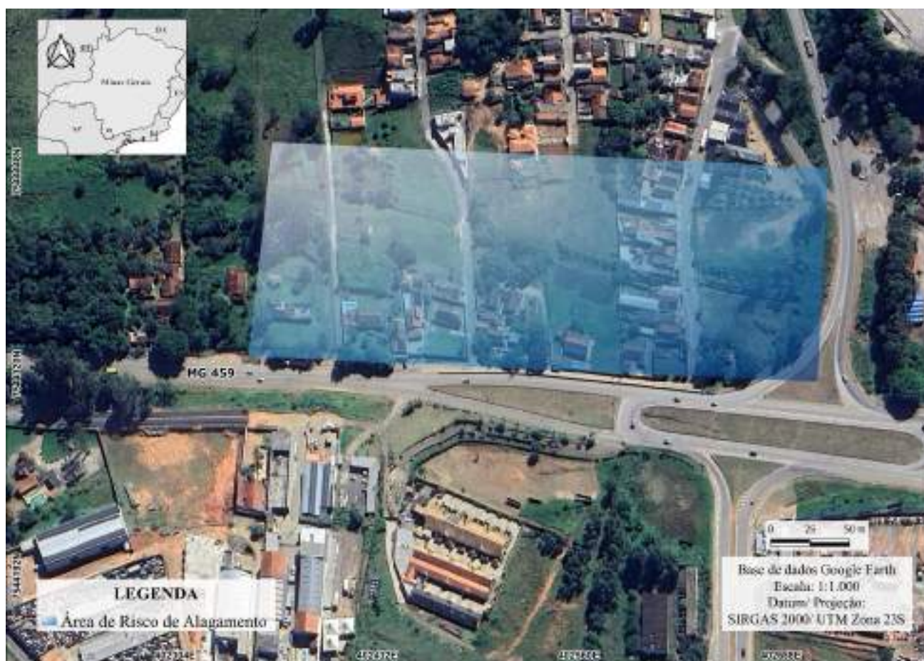
Figura 113 – Área de risco hidrológico 9 – bairro São Judas Tadeu
