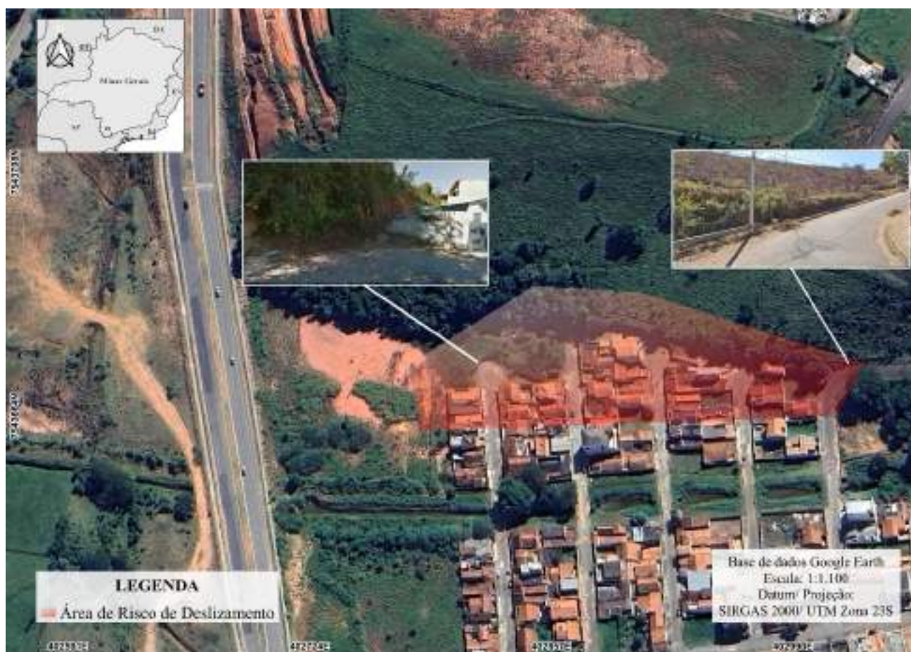
Figura 120 – Área de risco de deslizamento 4 – bairro Vale das Andorinhas
