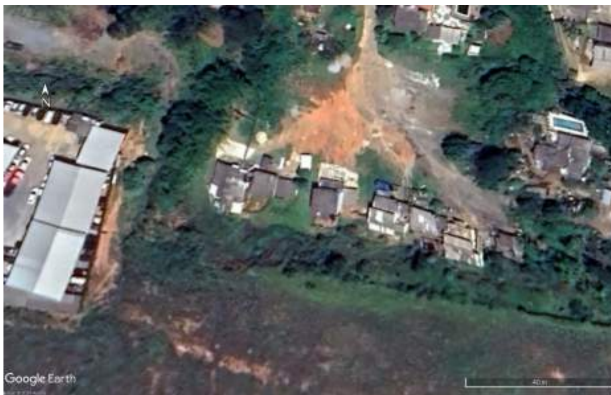
Figura 113 - Área em processo de deslizamento na BR-459 em 2022
