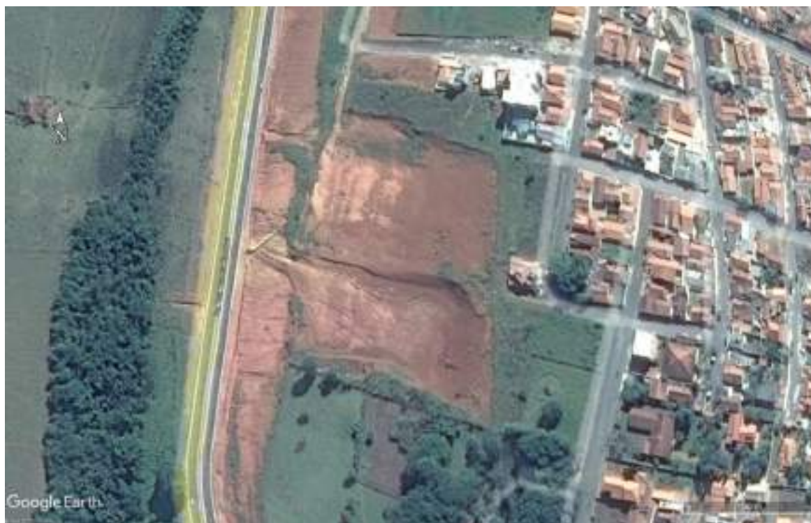
Figura 108 - Área em processo erosivo na Av. Ver. Hebert Campos em 2014
