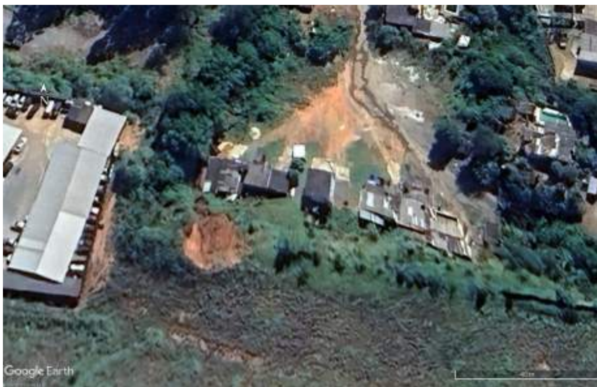
Figura 114 - Área em processo de deslizamento na BR-459 em 2023
