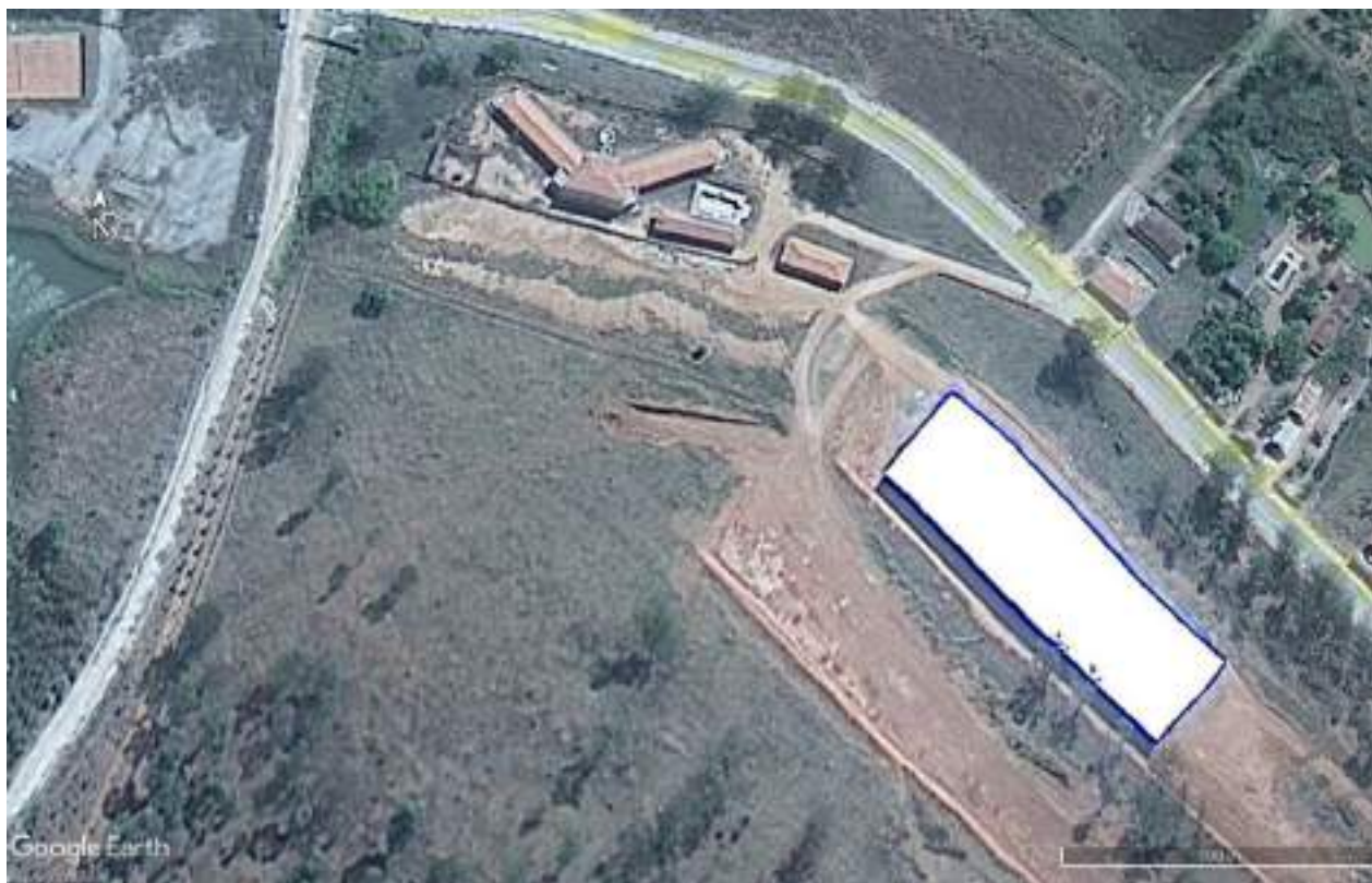
Figura 110 - Área em processo erosivo na Rua Antonio Scodeller em 2011
