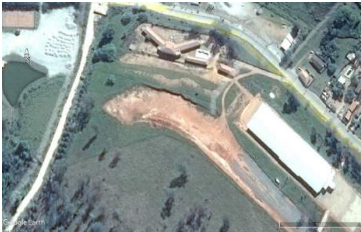
Figura 111 - Área em processo erosivo na Rua Antonio Scodeller em 2014
