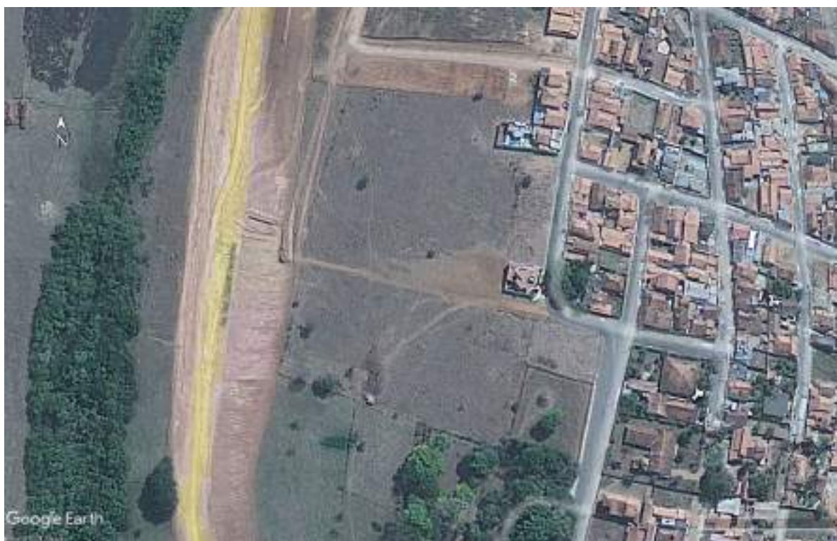
Figura 107 - Área em processo erosivo na Av. Ver. Hebert Campos em 2011
