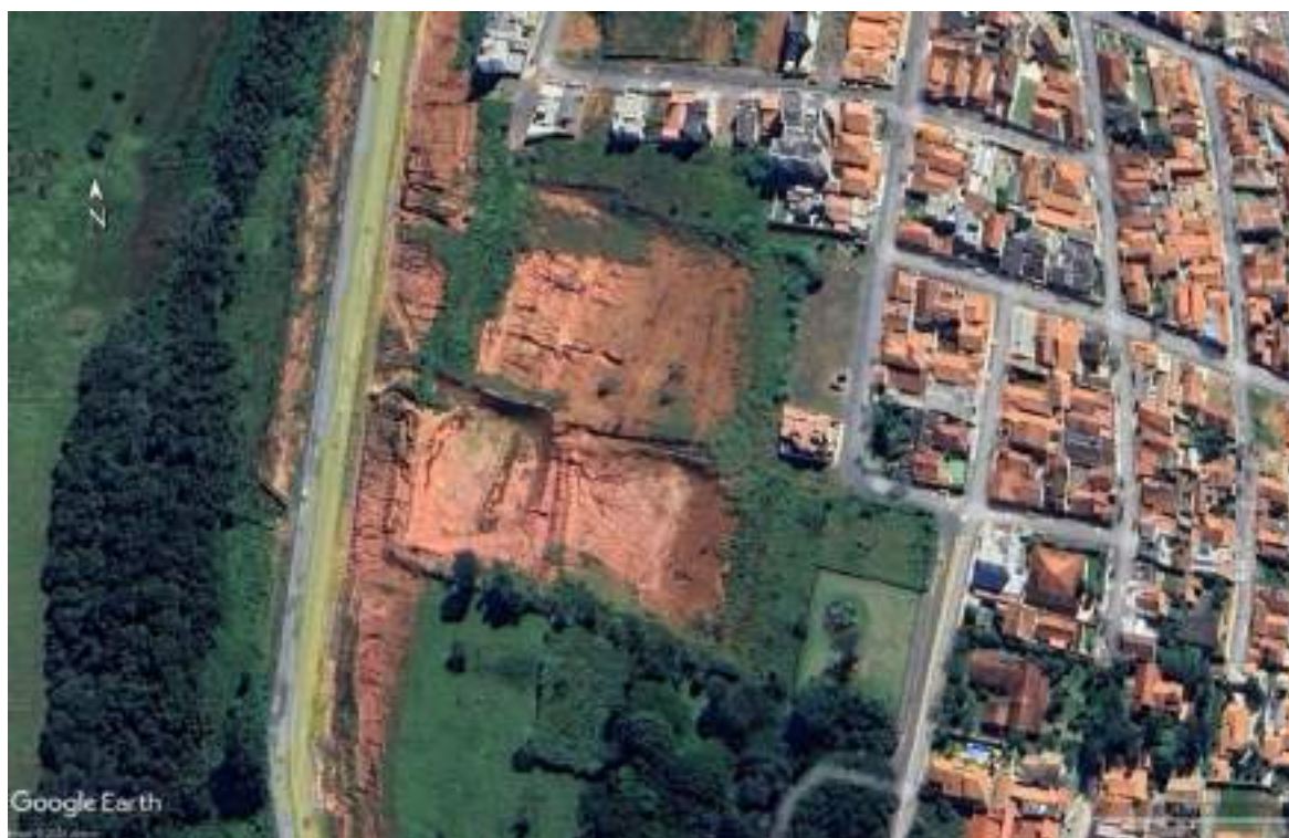
Figura 109 - Área em processo erosivo na Av. Ver. Hebert Campos em 2023
