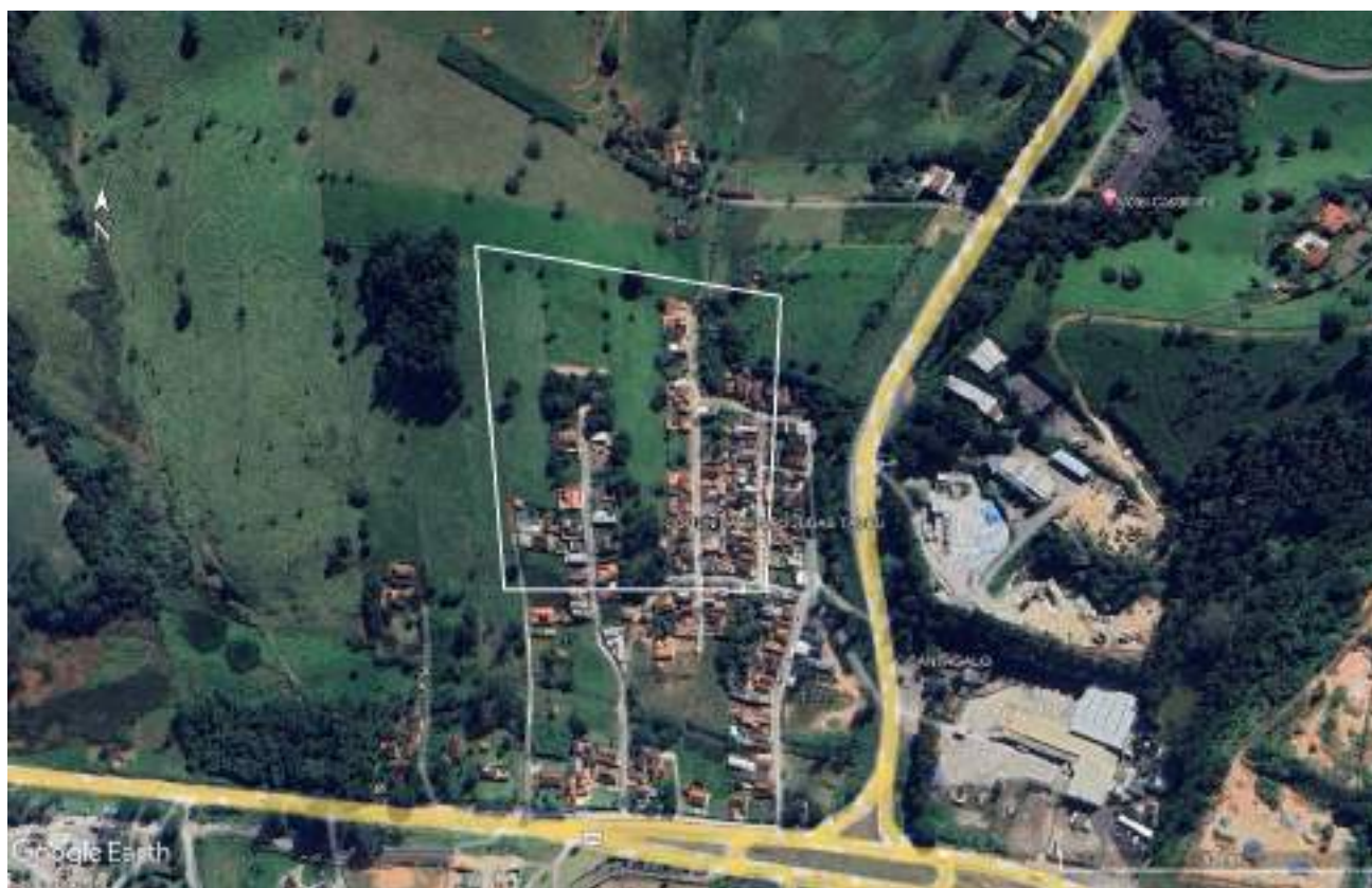
Figura 115 - Áreas de risco na Comunidade São Judas Tadeu
