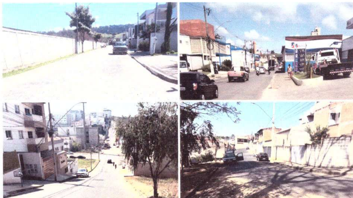
Figura 7 – Registros da iluminação pública nos bairros impactados
