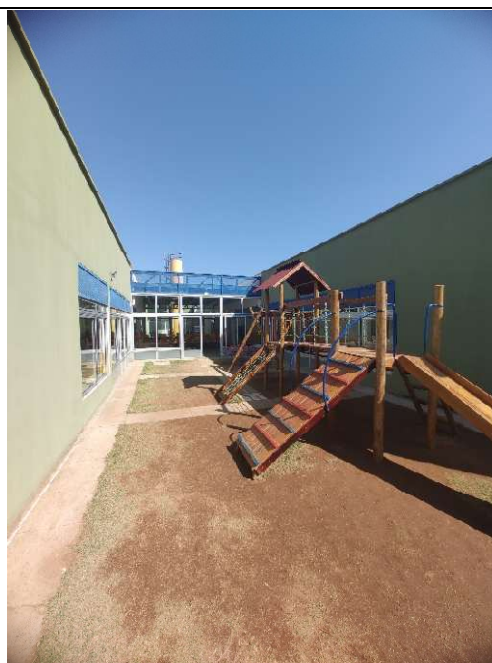
Figura 2 - Vista da área na creche Benedito Ap. da Cunha
