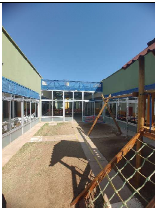
Figura 1 - Vista da área na creche Benedito Ap. da Cunha
