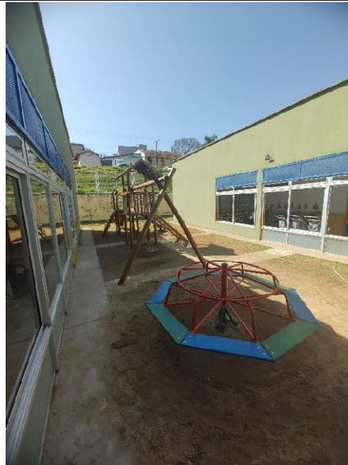
Figura 4 - Vista da área na creche Benedito Ap. da Cunha
