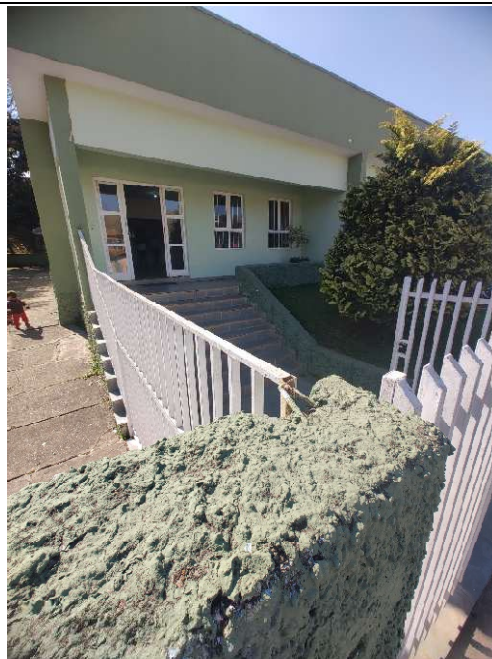
Figura 8 - Vista da área na creche Santa Terezinha
