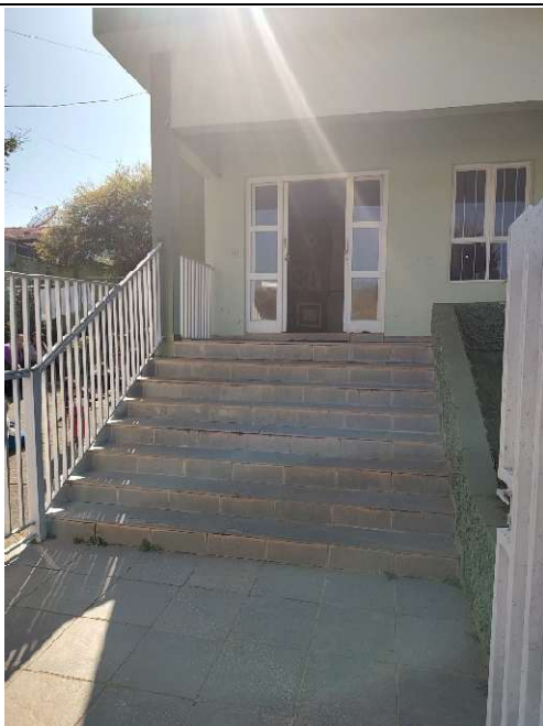
Figura 5 - Vista da área na creche Santa Terezinha
