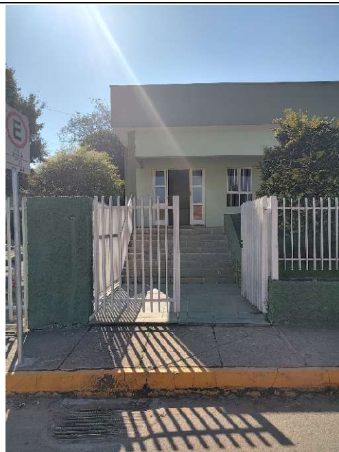
Figura 6 - Vista da área na creche Santa Terezinha
