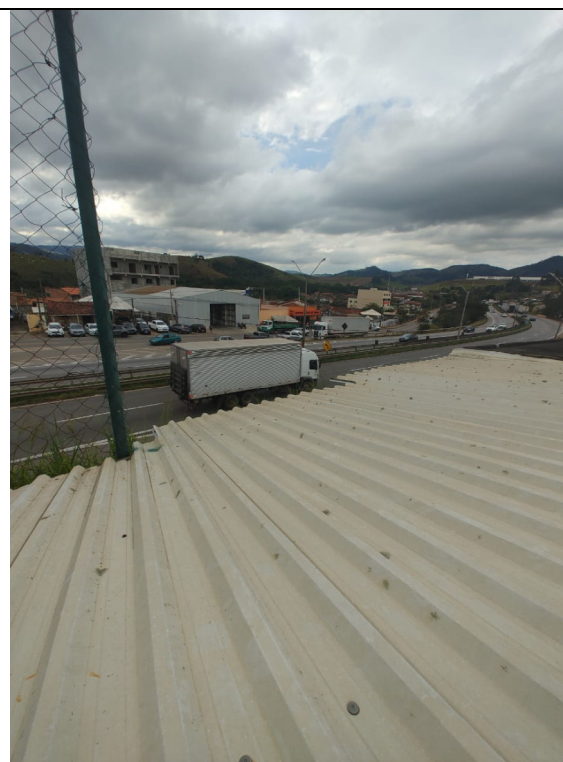
Figura 16 - Vista da área do telhado da cozinha
