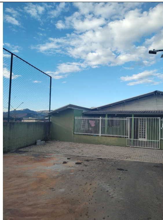
Figura 10 - Vista dos fundos da edificação
