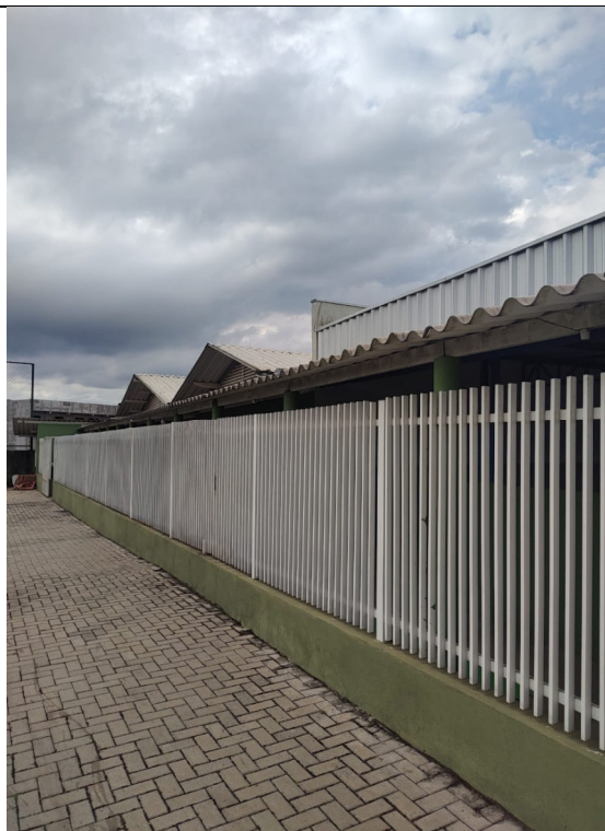
Figura 19 - Vista dos fundos da edificação
