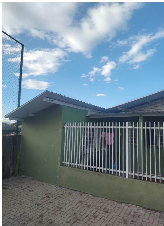
Figura 11 - Vista dos fundos da edificação
