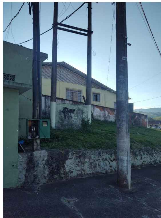
Figura 6 - Vista da fachada frontal
