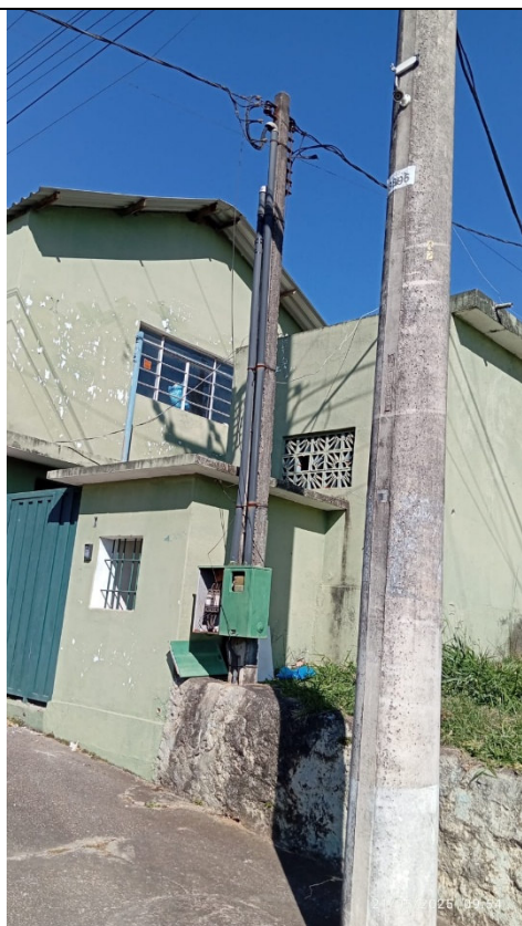
Figura 4 - Vista da fachada frontal
