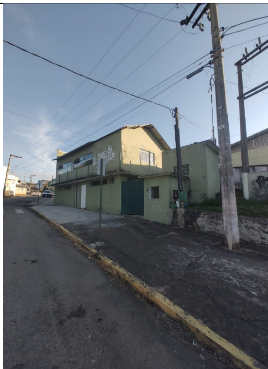
Figura 3 - Vista da fachada frontal
