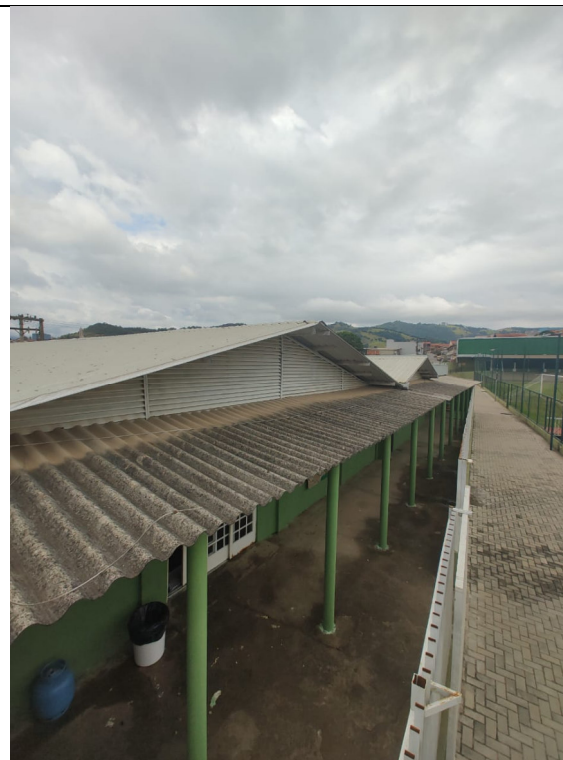
Figura 18 - Vista dos fundos da edificação
