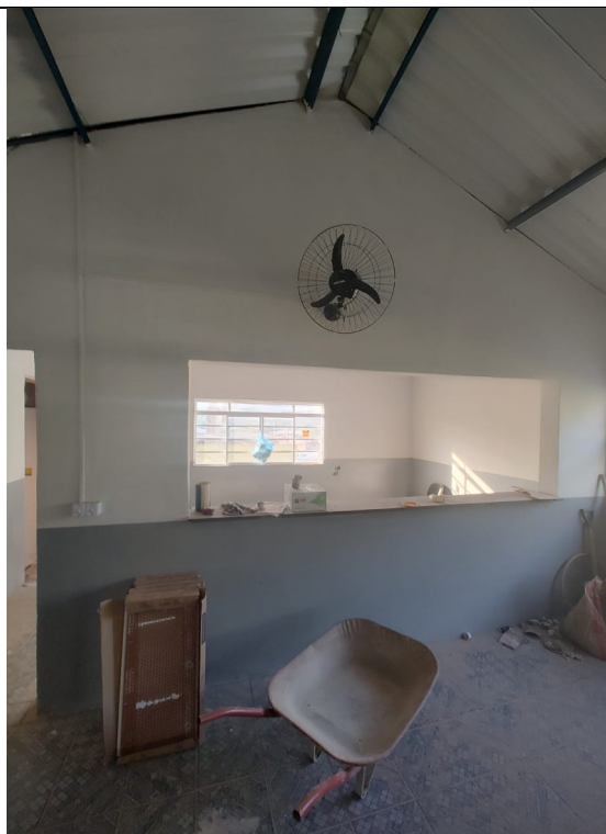
Figura 15 – Vista da sala 6
