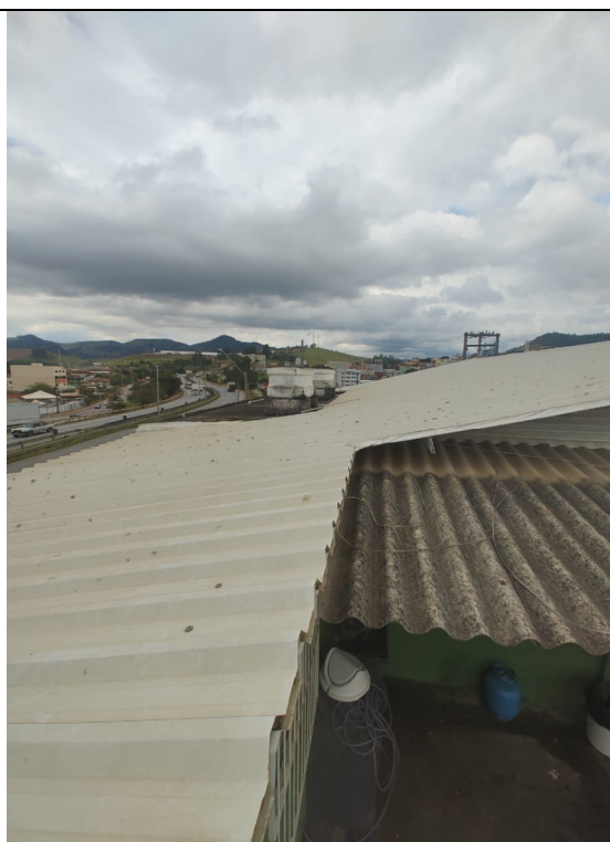
Figura 17 - Vista dos telhados da edificação
