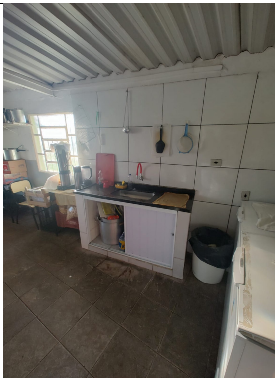
Figura 7 - Vista da cozinha existente
