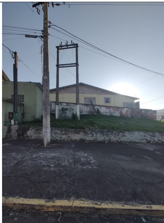
Figura 2 – Vista da fachada frontal
