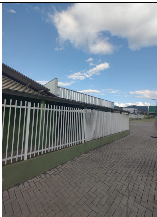
Figura 13 - Vista dos fundos da edificação
