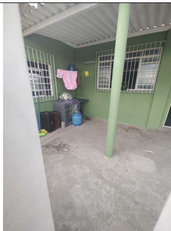
Figura 12 - Vista dos fundos da edificação, área que será ampliada a cozinha
