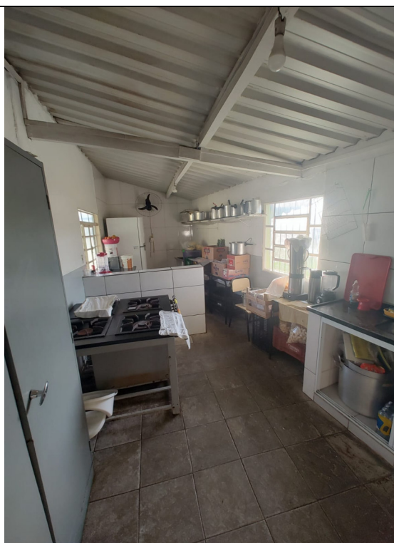
Figura 9 - Vista da cozinha existente
