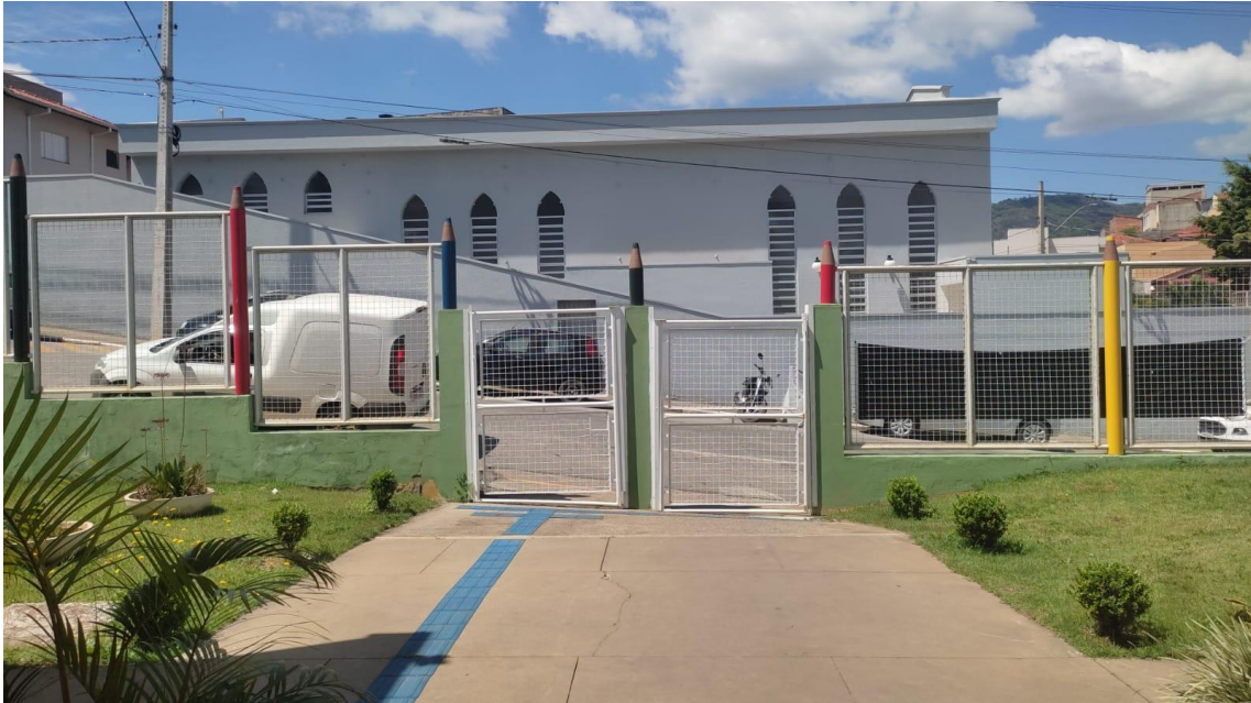
Figura 6- Vista da entrada da creche Ver. Benedito Ap. da Cunha
