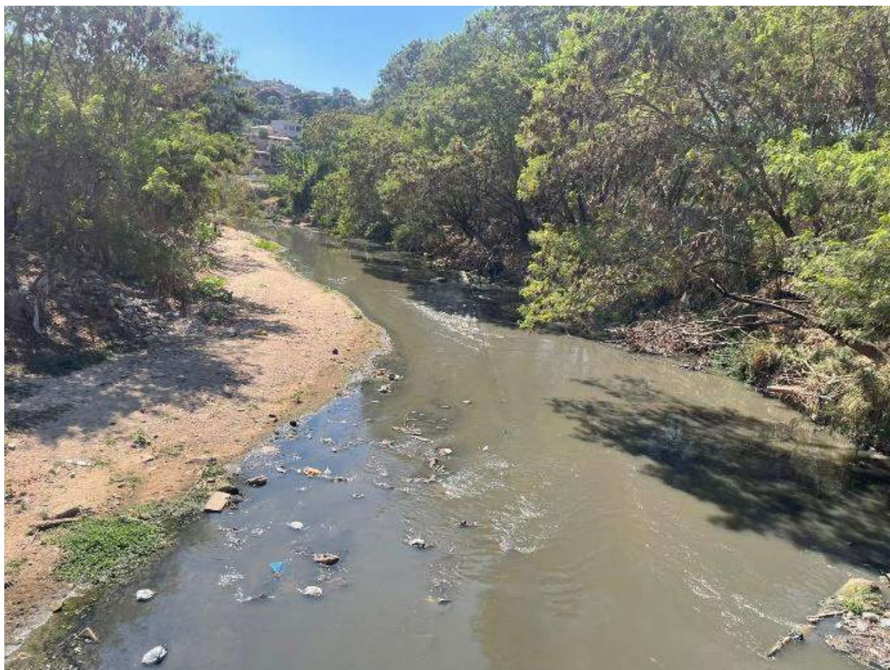
Figura 3: Situação atual do Ribeirão do Onça na área de estudo do projeto, evidenciando o curso d'água com sinais de antropização e assoreamento. No lado direito, são observados vestígios de mata ciliar. Fonte: GLUAI, 2024.
