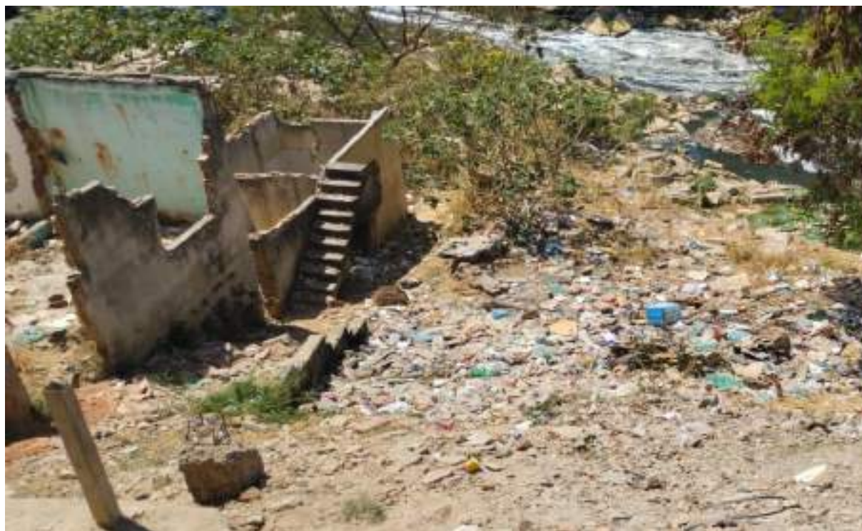
Figura 14: Remoção de residências em andamento e evidências de resíduos irregulares nas margens do curso d'água. Fonte: GLUAI, 2024.
