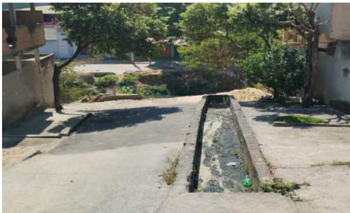
Figura 13: Evidência rede de drenagem adaptada nas margens do Ribeirão do Onça. Fonte: GLUAI, 2024.
