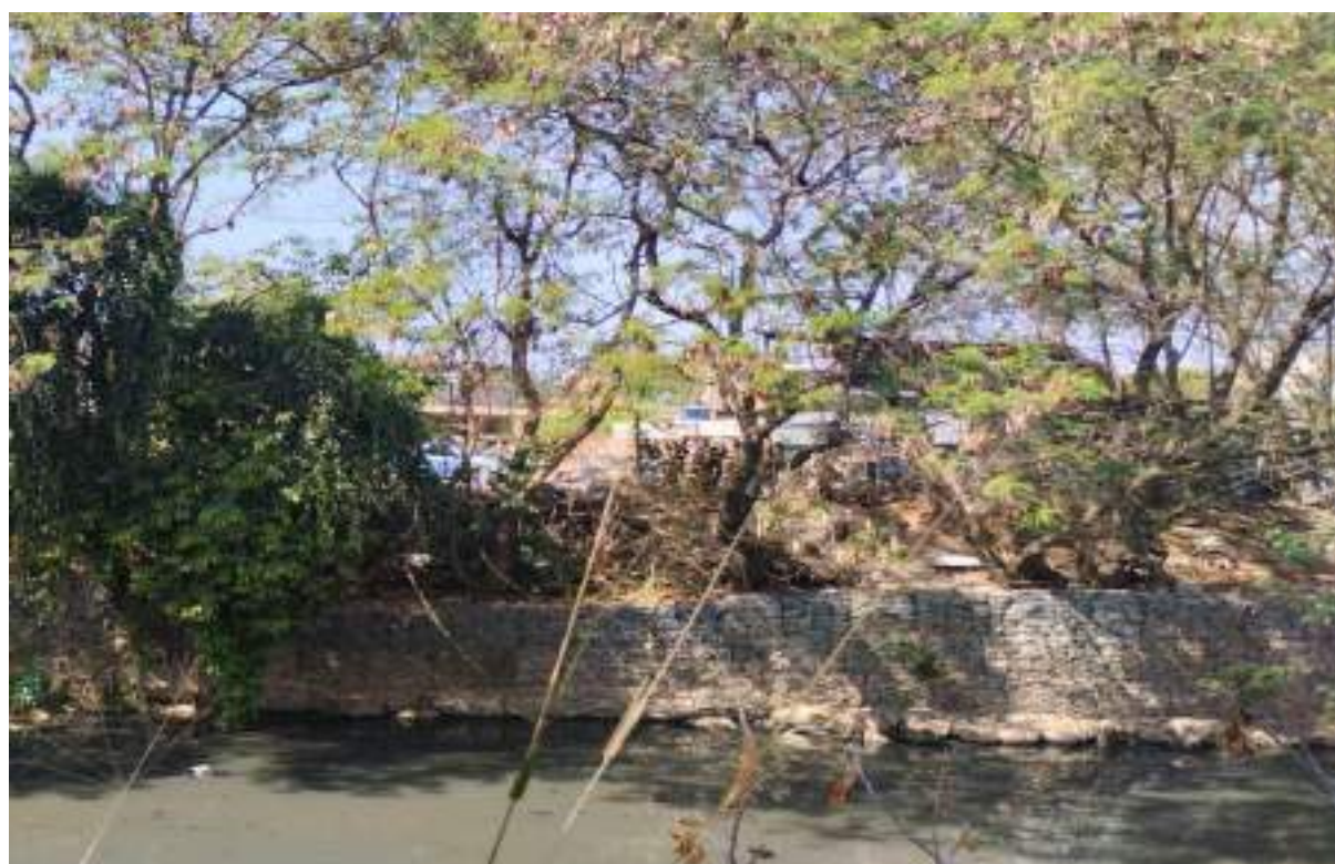
Figura 5: Presença de gabião comprometido e a ocorrência de espécies invasoras (leucenas) na área circundante ao curso d'água. Fonte: GLUAI, 2024.
