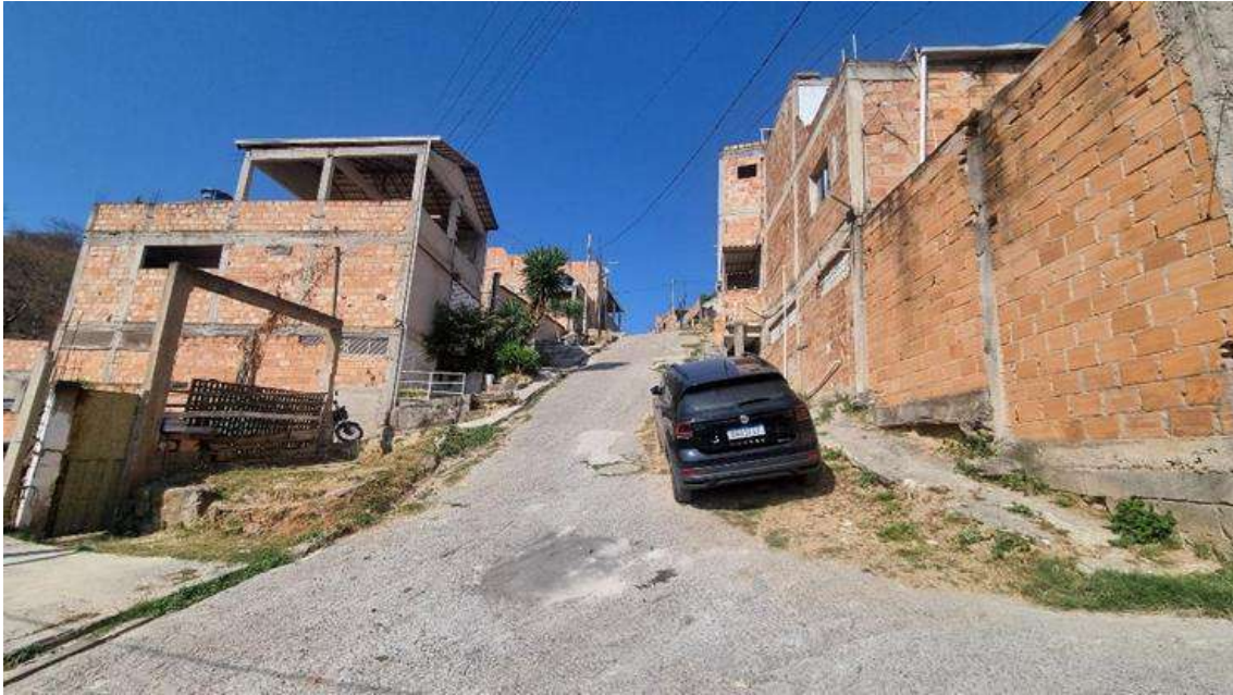
Foto 11: Vista da Rua Flor de Cerejeira a partir da esquina com a Rua Flor de Liz. Trecho pavimentado da via, porém ainda sem infraestrutura. As casas à esquerda da foto deverão ser removidas.
