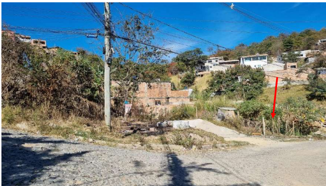
Foto 07: Rua Flor D'Água, esquina com Rua Flor do Vale. Local por onde o córrego passa antes de atravessar a Rua Flor D'Água (em destaque).
