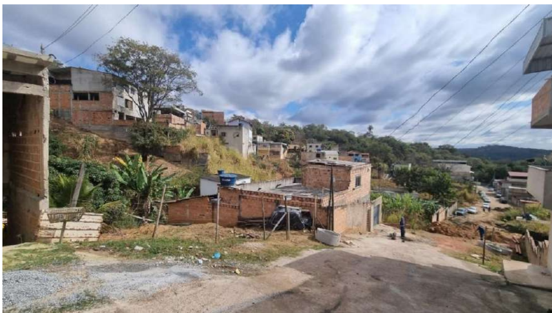
Foto 01: Vista da Rua Flor do Vale. À esquerda, jusante do talvegue. Foto: Julho de 2023.
