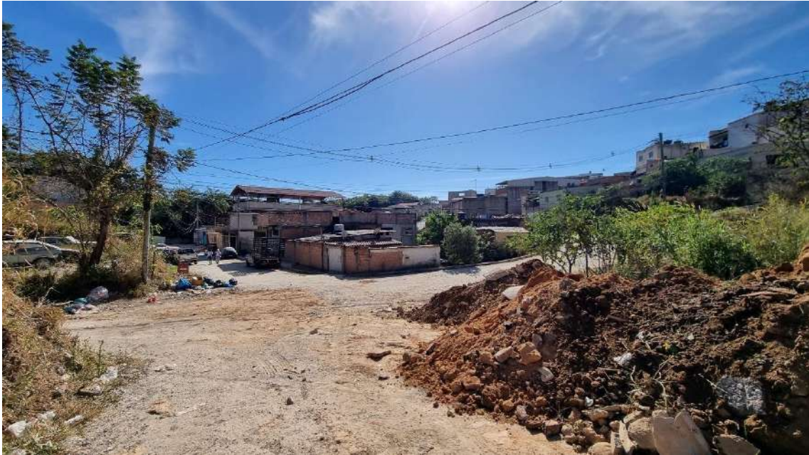
Foto 02: Vista da Rua Flor do Vale, esquina com Rua Flor D'Água. À direita da foto, terra retirada para implantação da tubulação da Copasa. Foto: Junho de 2024.
