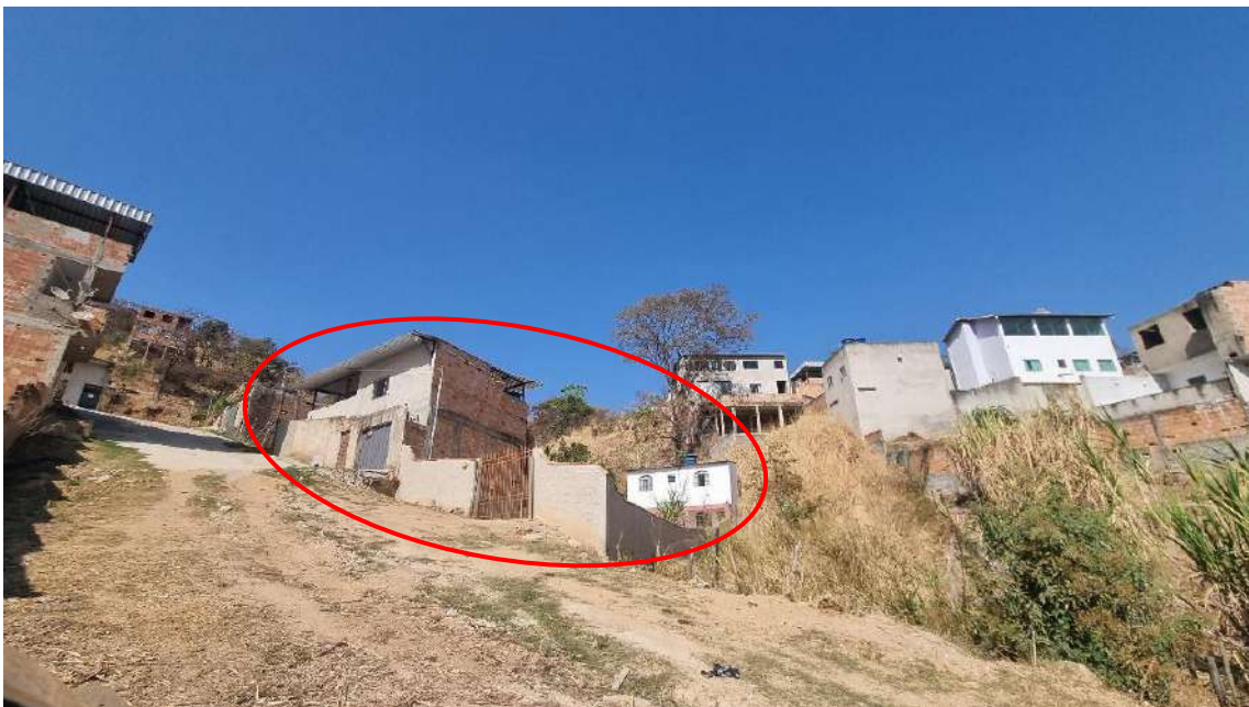
Fotos 03: Vista do talvegue da Rua Flor do Vale, a partir da mesma. Edificações que serão removidas (em destaque) para tratamento da APP.
