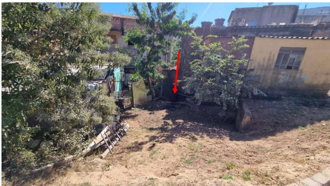
Foto 9: Vista a partir da Rua Flor D'Água, interior da quadra. Local por onde passa o córrego (em destaque), debaixo da estrutura da edificação à direita.
