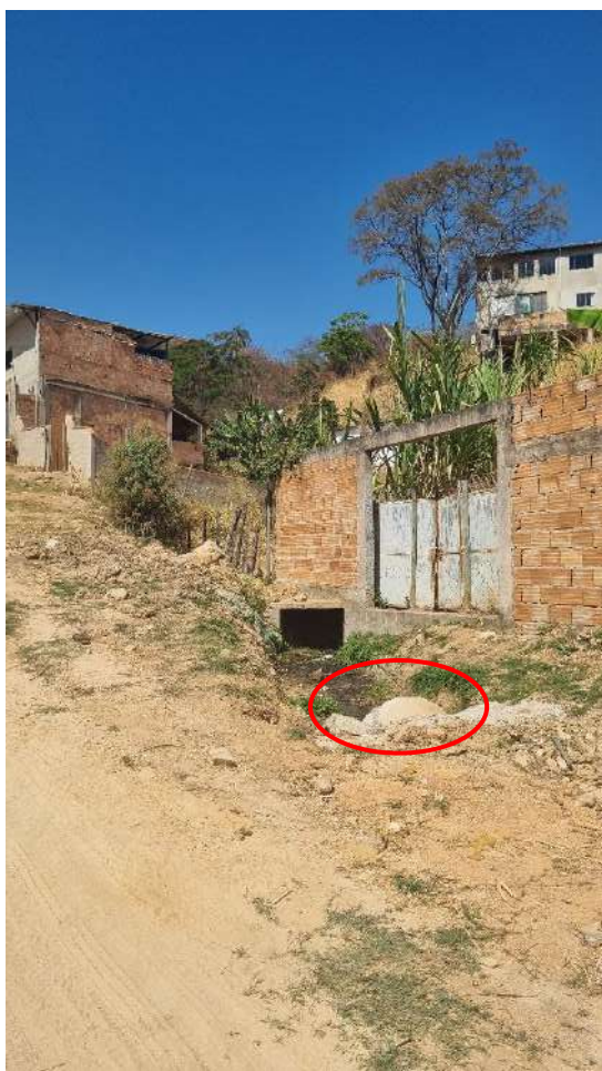
Foto 05 e 06: Vista da canalização do córrego saindo do talvegue, parte da tubulação utilizada (em destaque) para transpor a Rua Flor do Vale e local onde o córrego chega, na esquina com a Rua Flor D'Água.
