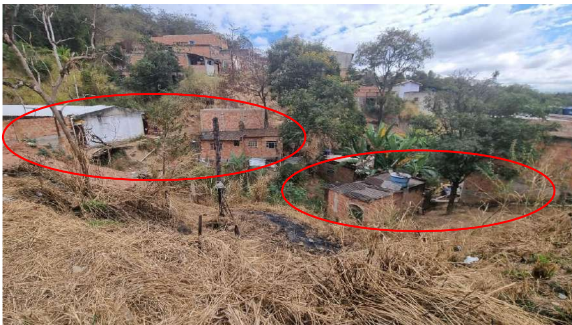
Fotos 04: Vista do talvegue da Rua Flor do Vale, a partir da mesma. Edificações que serão removidas (em destaque) para tratamento da APP.
