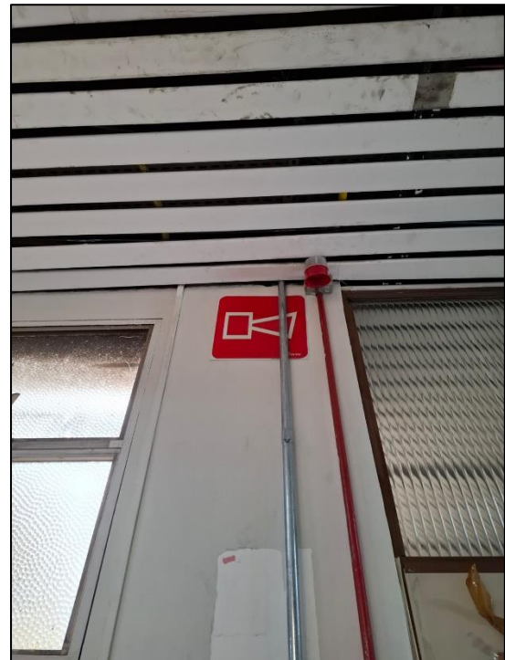
Figuras 8 e 9 – Percurso dos cabos elétricos até o quadro de energia.
