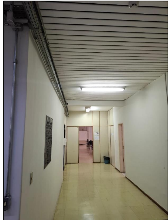
Figuras 6 e 7 – Percurso dos cabos elétricos até o quadro de energia.
