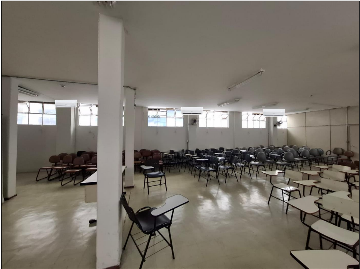
Figura 4 – Local previsto para instalação das evaporadoras.
