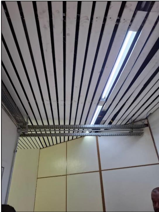
Figuras 6 e 7 – Percurso dos cabos elétricos até o quadro de energia.
