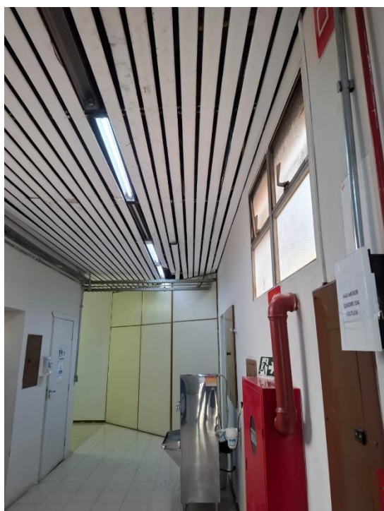
Figuras 8 e 9 – Percurso dos cabos elétricos até o quadro de energia.
