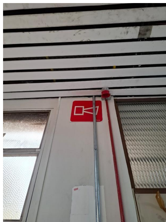
Figuras 8 e 9 – Percurso dos cabos elétricos até o quadro de energia.
