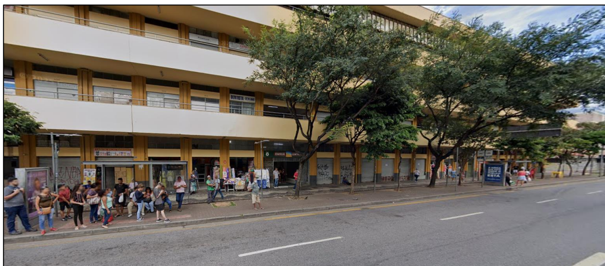
Figura 1 – Fachada do prédio.
