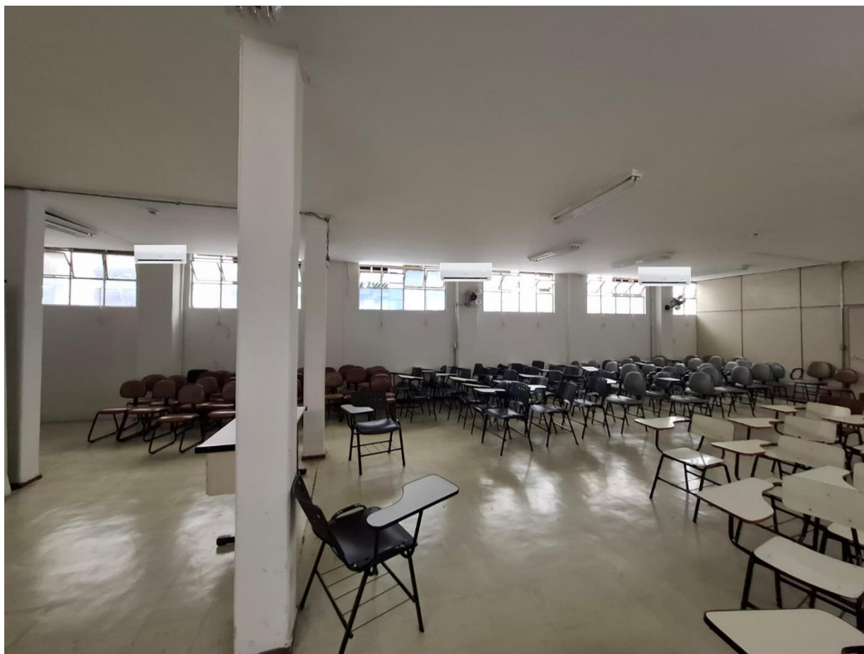
Figura 4 – Local previsto para instalação das evaporadoras.
